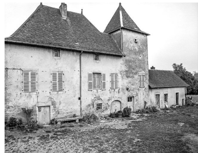
Demeure située au lieudit La Grange Rouge. Phot. Yves Sancey IVR43_19843900075X
