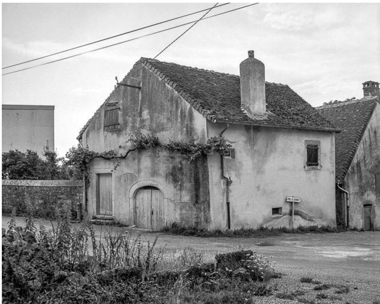
Maison de vigneron située chemin des Vannodes.
