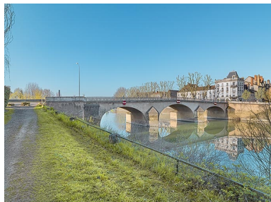
Vue d'ensemble du pont.
