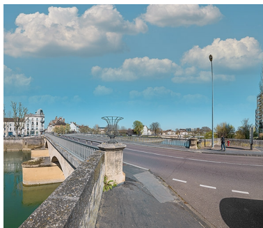
Vue d'ensemble du pont depuis la chaussée.
