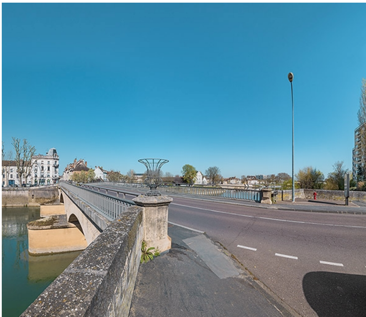
Vue d'ensemble du pont depuis la chaussée.
