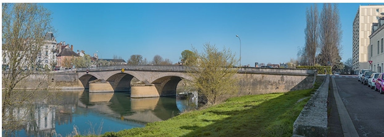
Vue d'ensemble, d'aval.
