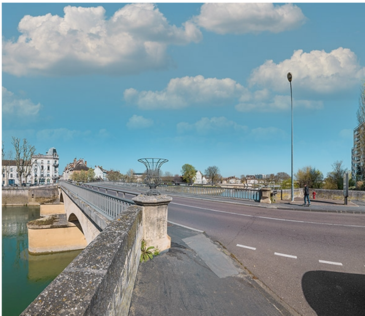
Vue d'ensemble du pont depuis la chaussée.
