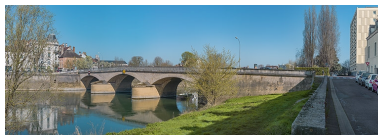
Vue d'ensemble, d'aval.
