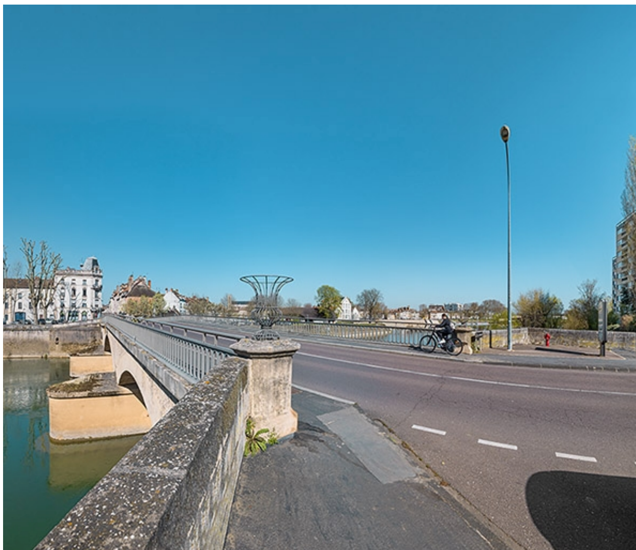
Vue d'ensemble du pont depuis la chaussée.
