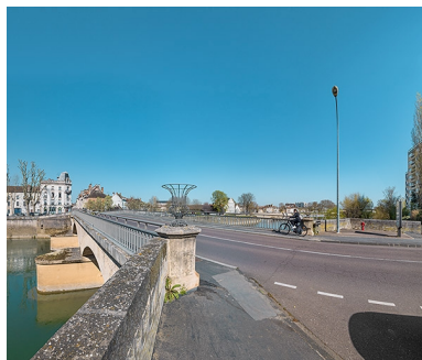
Vue d'ensemble du pont depuis la chaussée.
