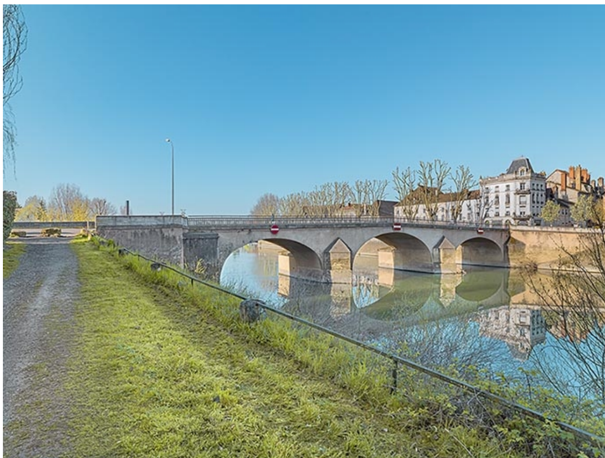
Vue d'ensemble du pont.
