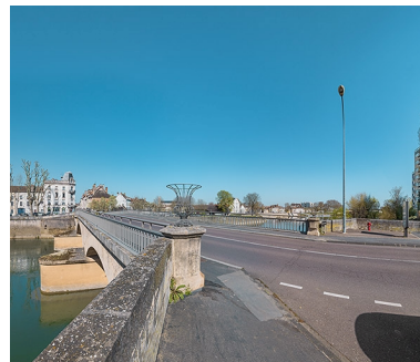
Vue d'ensemble du pont depuis la chaussée.
