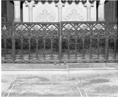
Partie centrale Phot. Michel Thierry IVR26_19862101022X
