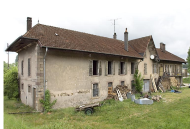
Vu de trois quarts arrière. Phot. Jérôme Mongreville IVR43_20077000261NUCA
