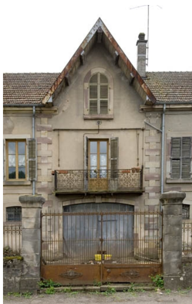
Façade antérieure. Pignon central. Phot. Jérôme Mongreville IVR43_20077000262NUCA
