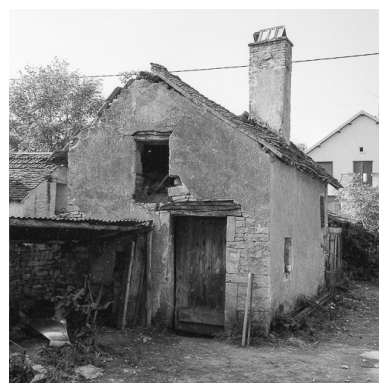
Vue du four depuis la cour. Phot. Bernard Lardière IVR43_19797000333Z
