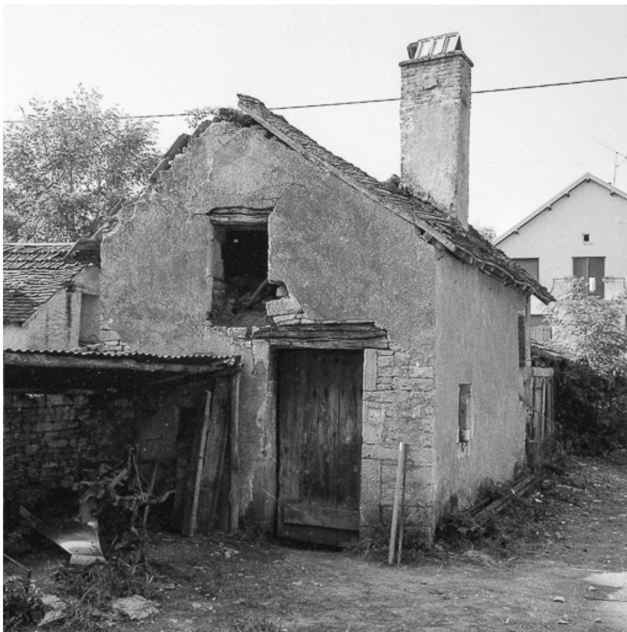
Vue du four depuis la cour.
