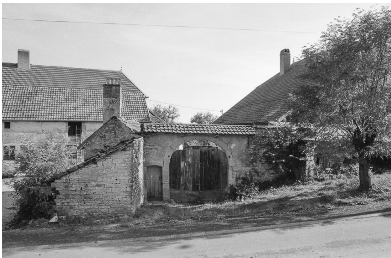
Vue du four depuis la rue.
