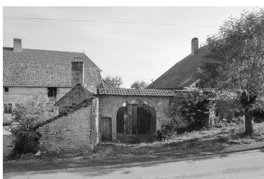
Vue du four depuis la rue. Phot. Bernard Lardière IVR43_19797000332Z
