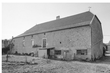
Façade postérieure. Phot. Bernard Lardière IVR43_19797000330Z
