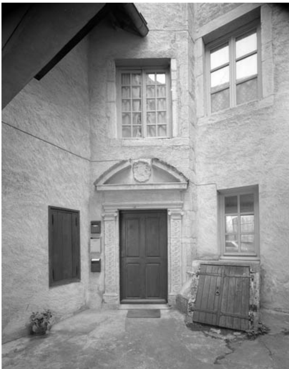
Détail : porte d'entrée de l'escalier en vis.
