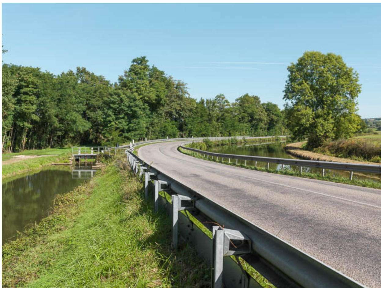
Vue du petit barrage à deux vannes.
