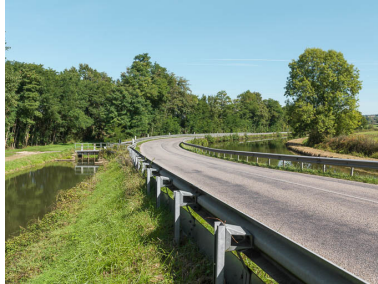
Vue du petit barrage à deux vannes. Phot. Pierre-Marie Barbe-Richaud IVR26_20177100378NUC2A
