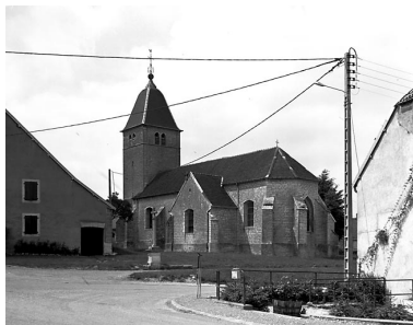
Chevet et façade latérale droite. Phot. Yves Sancey IVR43_19837000151V
