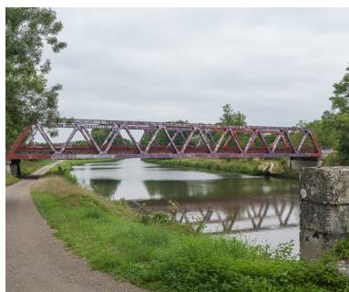
Vue du pont.
