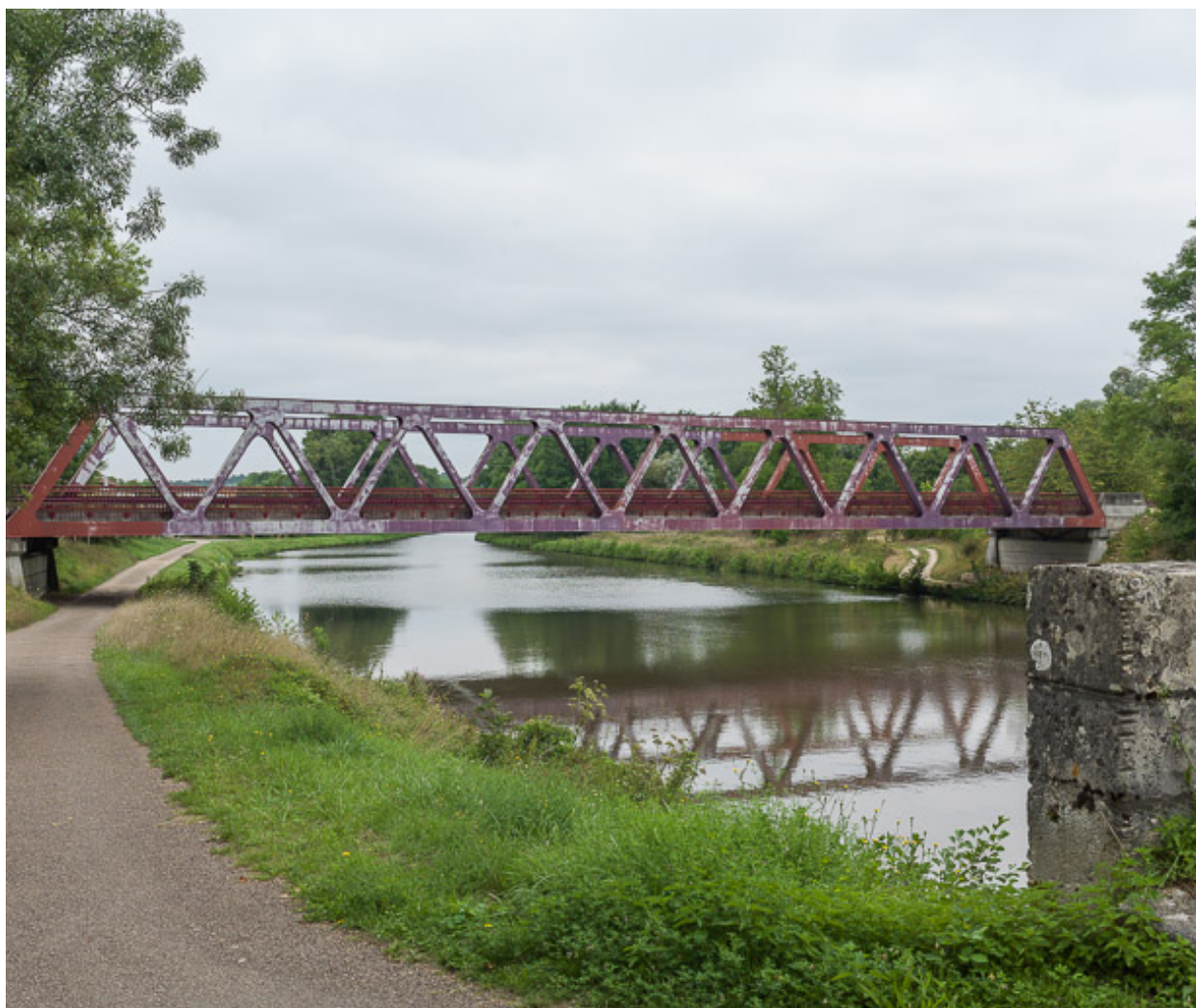
Vue du pont.
