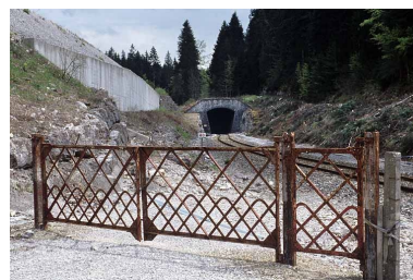
Vue d'ensemble. Phot. Yves Sancey IVR43_20053900303ZA
