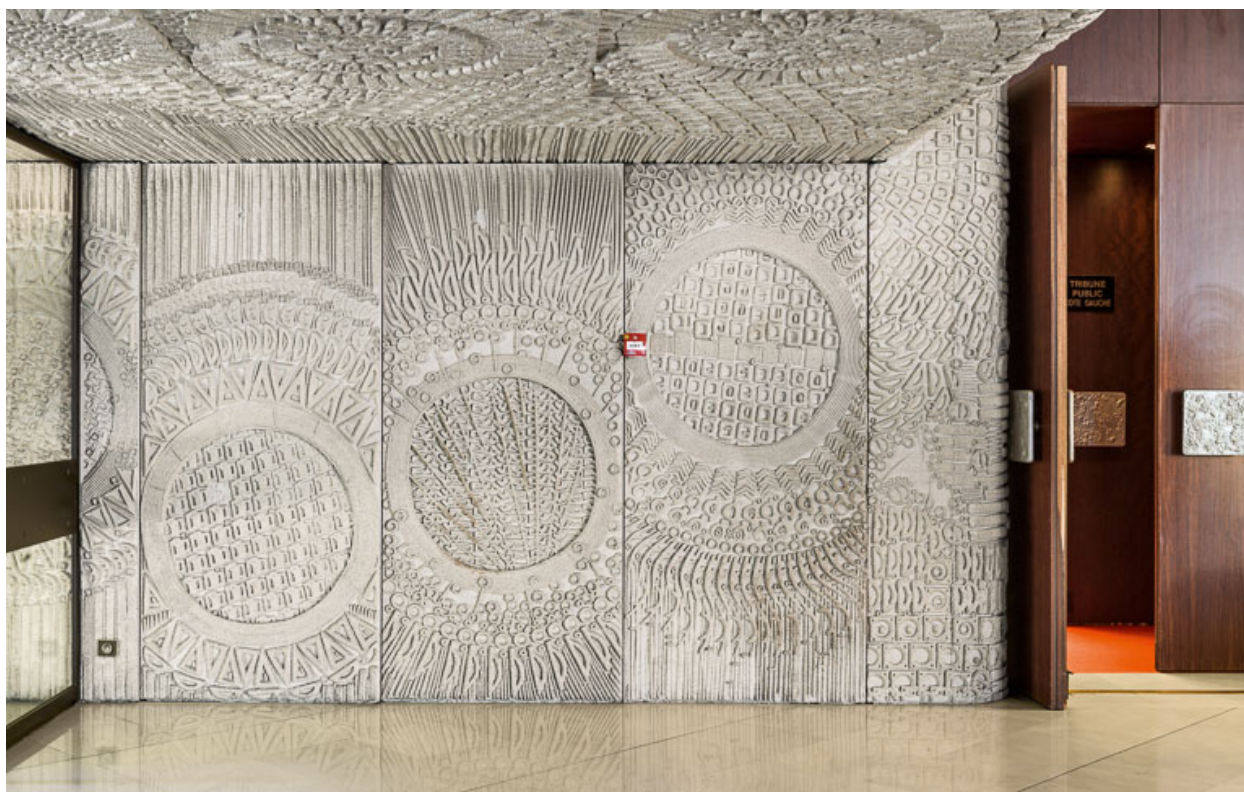
Hall d'accueil : panneaux moulés à l'entrée.
