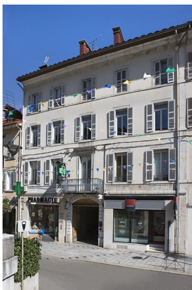
Élévation antérieure. Phot. Yves Sancey IVR43_20093900150NUC2A
