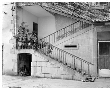
Escalier sud : cage ouverte au rez-de-chaussée. Phot. Yves Sancey IVR43_20033900740X
