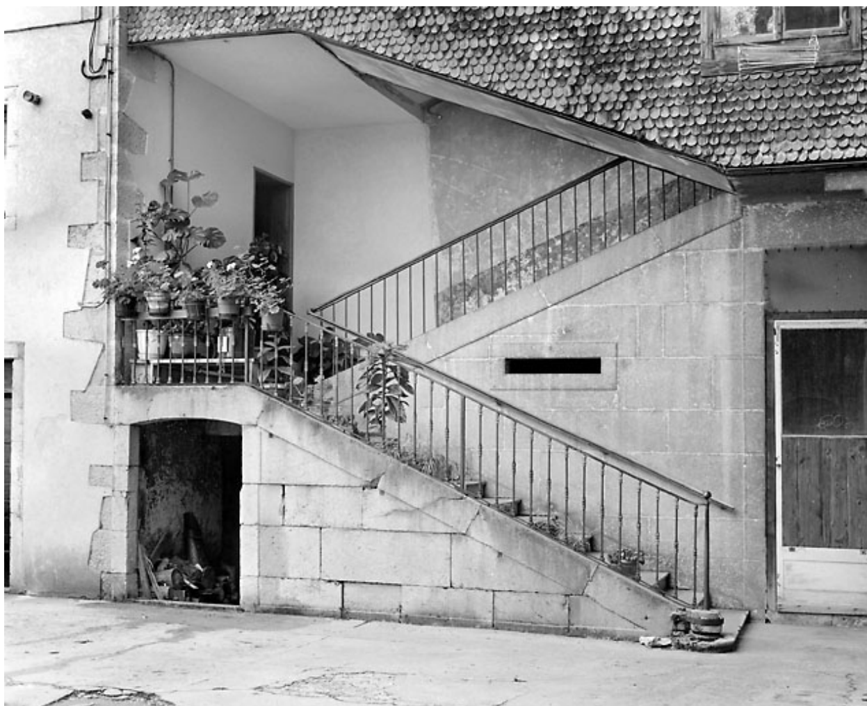
Escalier sud : cage ouverte au rez-de-chaussée.
