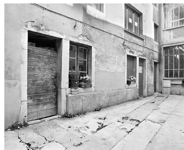
Aile nord : rez-de-chaussée, de trois quarts gauche. Phot. Yves Sancey IVR43_20033900744X
