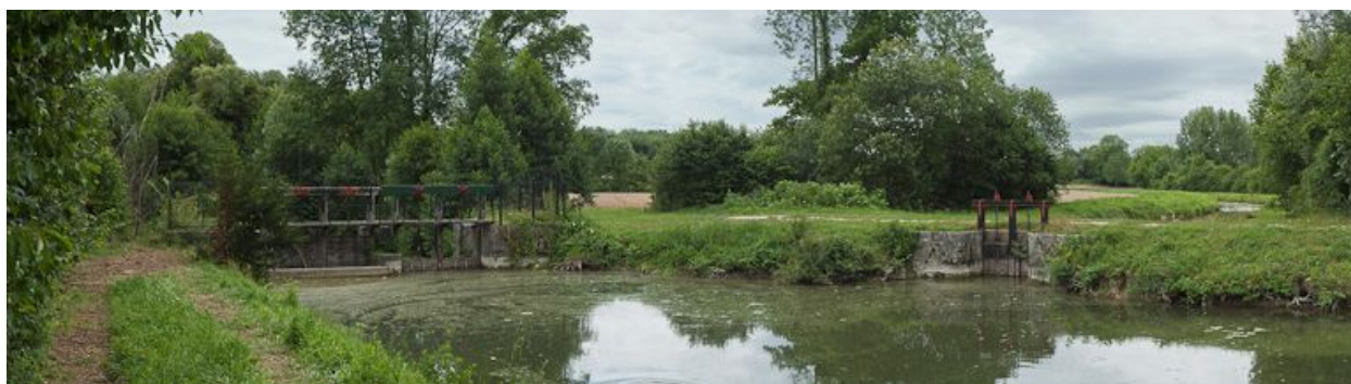
Vue des vannes de prise d'eau.
