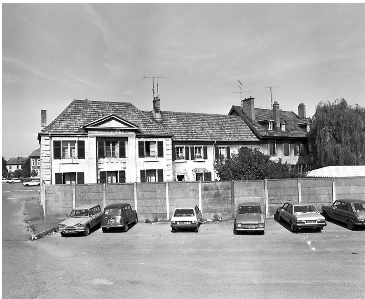
Façade antérieure, cour de l'orangerie.
