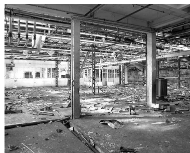
Intérieur du bâtiment (3). Phot. Yves Sancey IVR43_19932500027X
