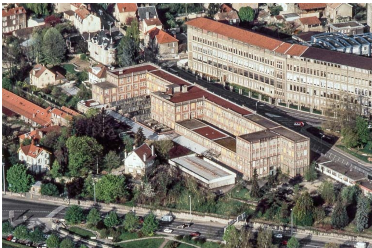
Vue aérienne de l'usine, depuis l'est.
