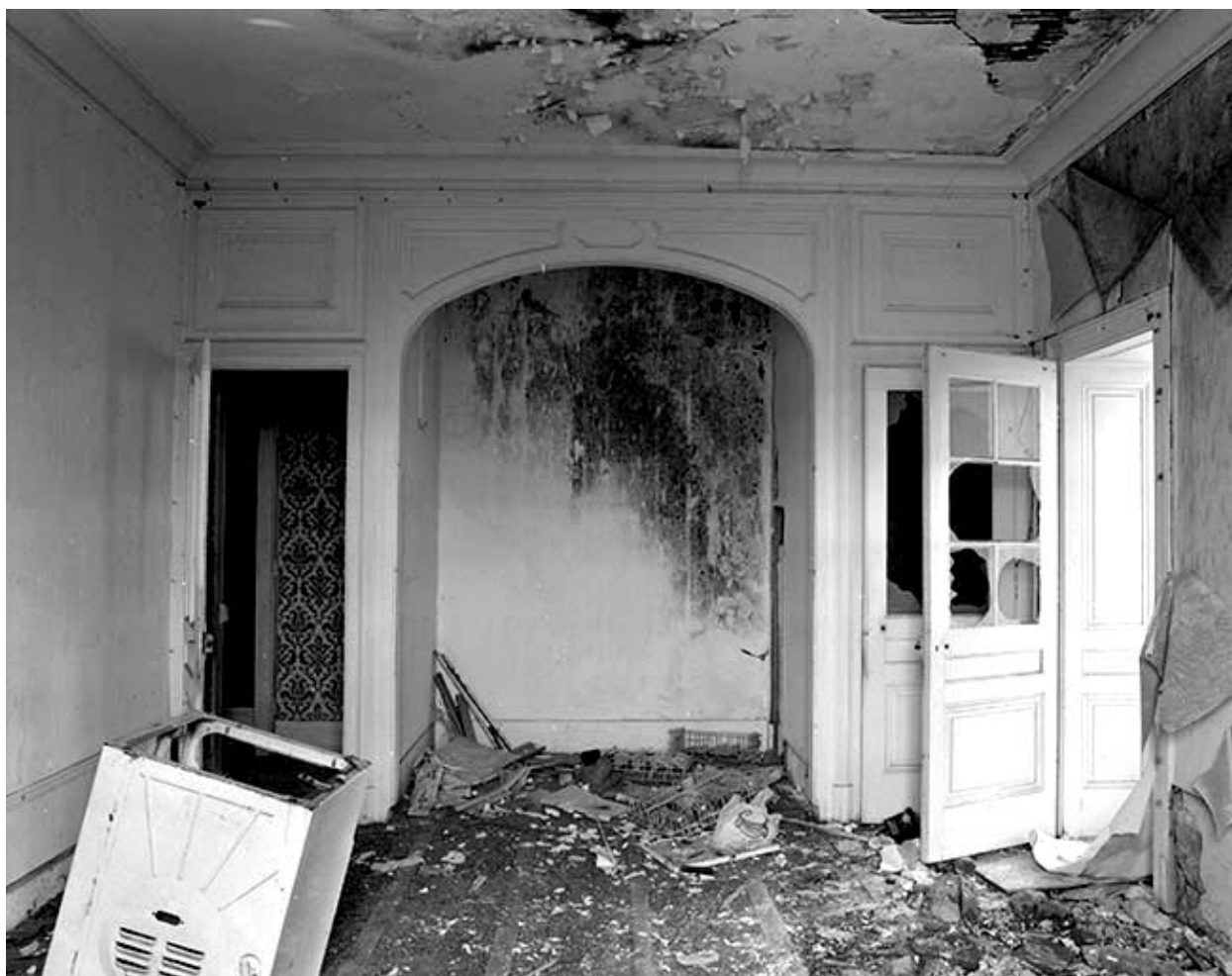
Boiserie au rez-de-chaussée du logement d'ouvriers (19).
