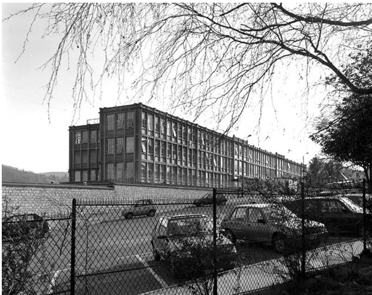
Façade antérieure et façade latérale gauche.
