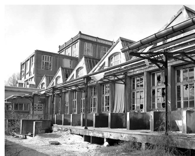
Façade du bâtiment (3). Phot. Yves Sancey IVR43_19932500020X
