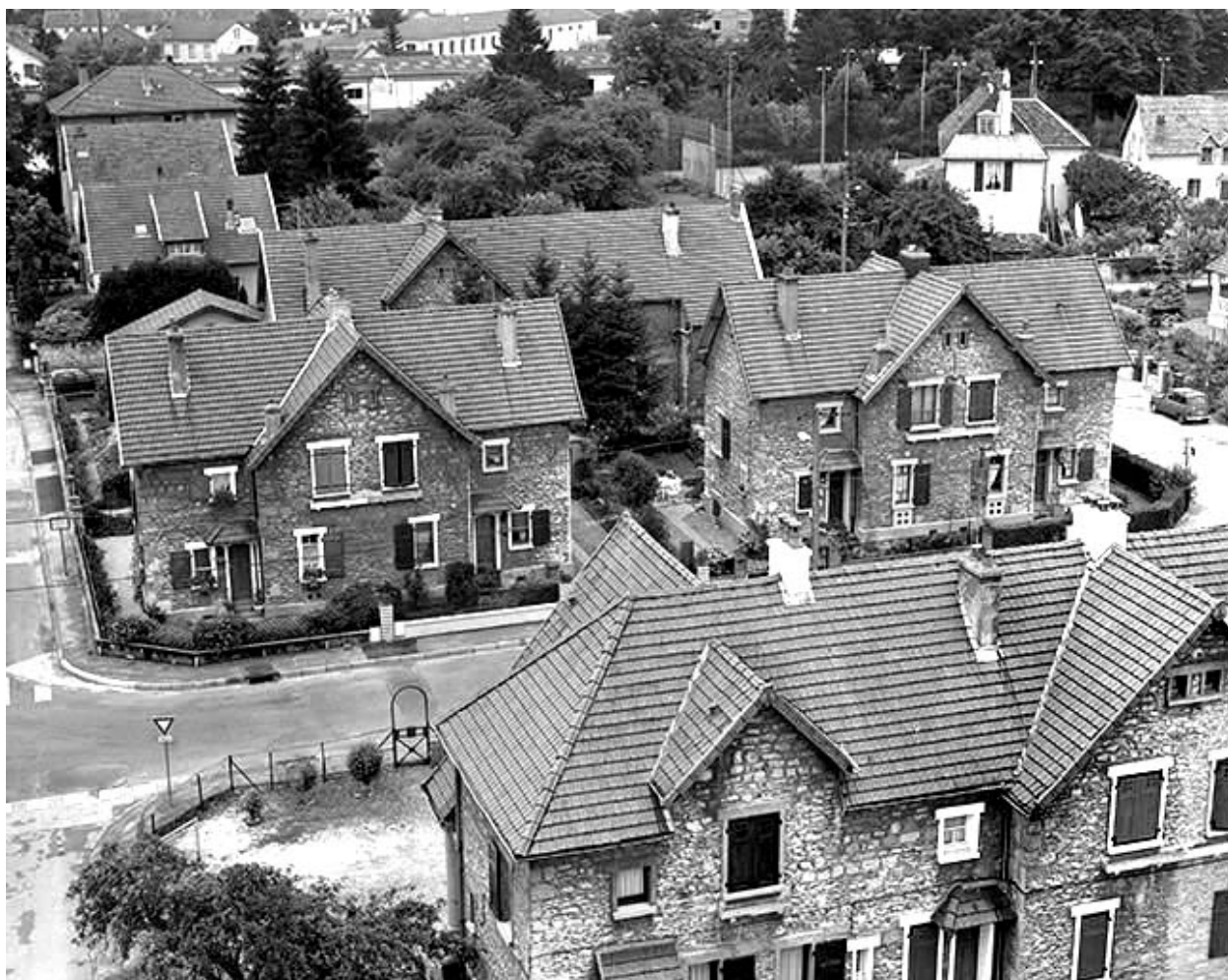
Maisons de type 1, rue du Bougney.
