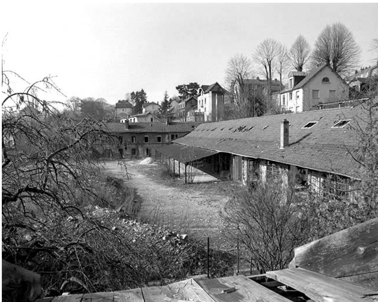
Logement d'ouvriers (21) et menuiserie.
