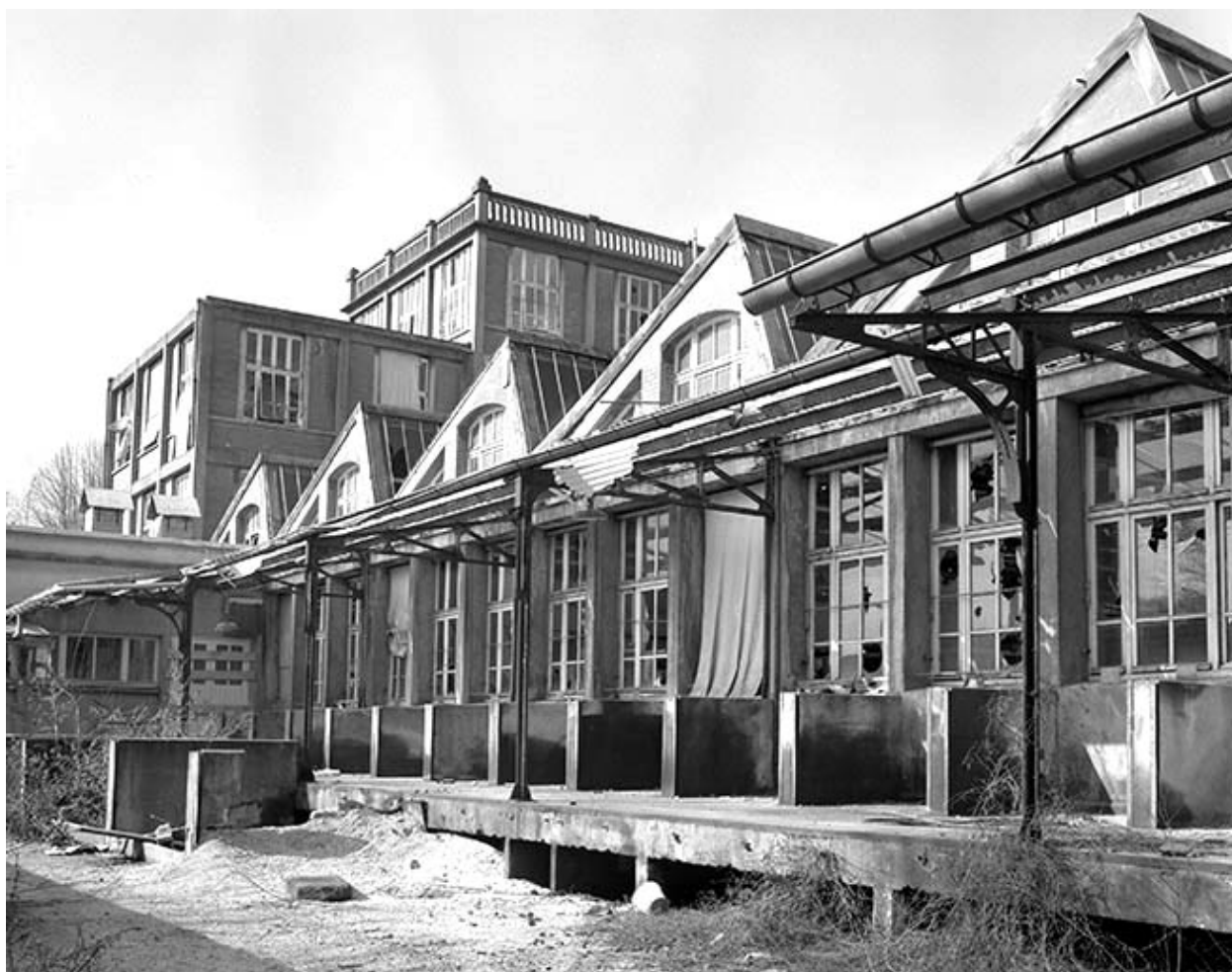
Façade du bâtiment (3).
