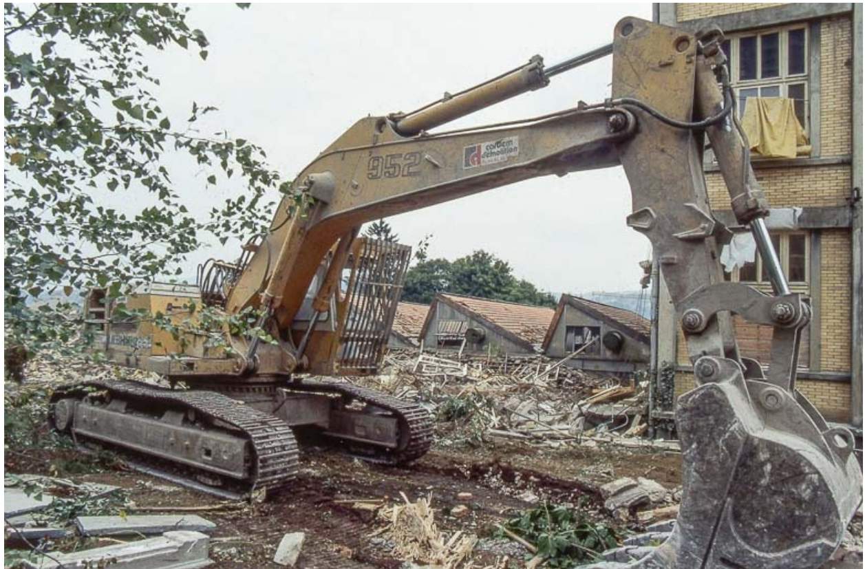
Destruction de l'usine, 23 août 1993 : pelle mécanique.
