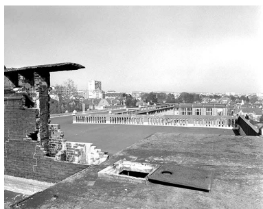
Toit terrasse des bâtiments (6, 8, 9). Phot. Yves Sancey
