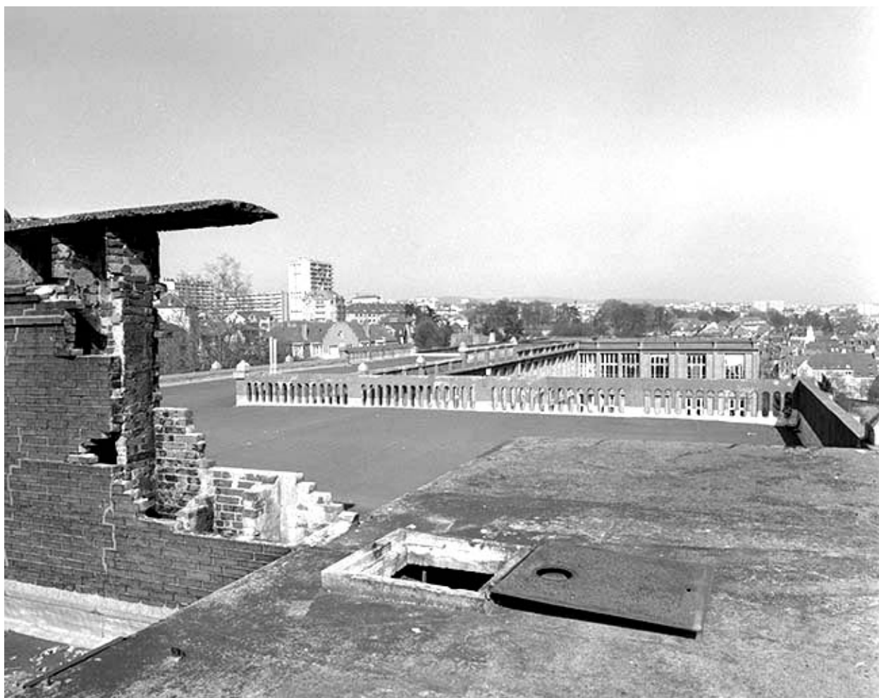
Toit terrasse des bâtiments (6, 8, 9).
