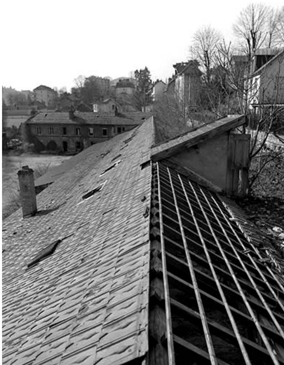
Toiture de la menuiserie.
