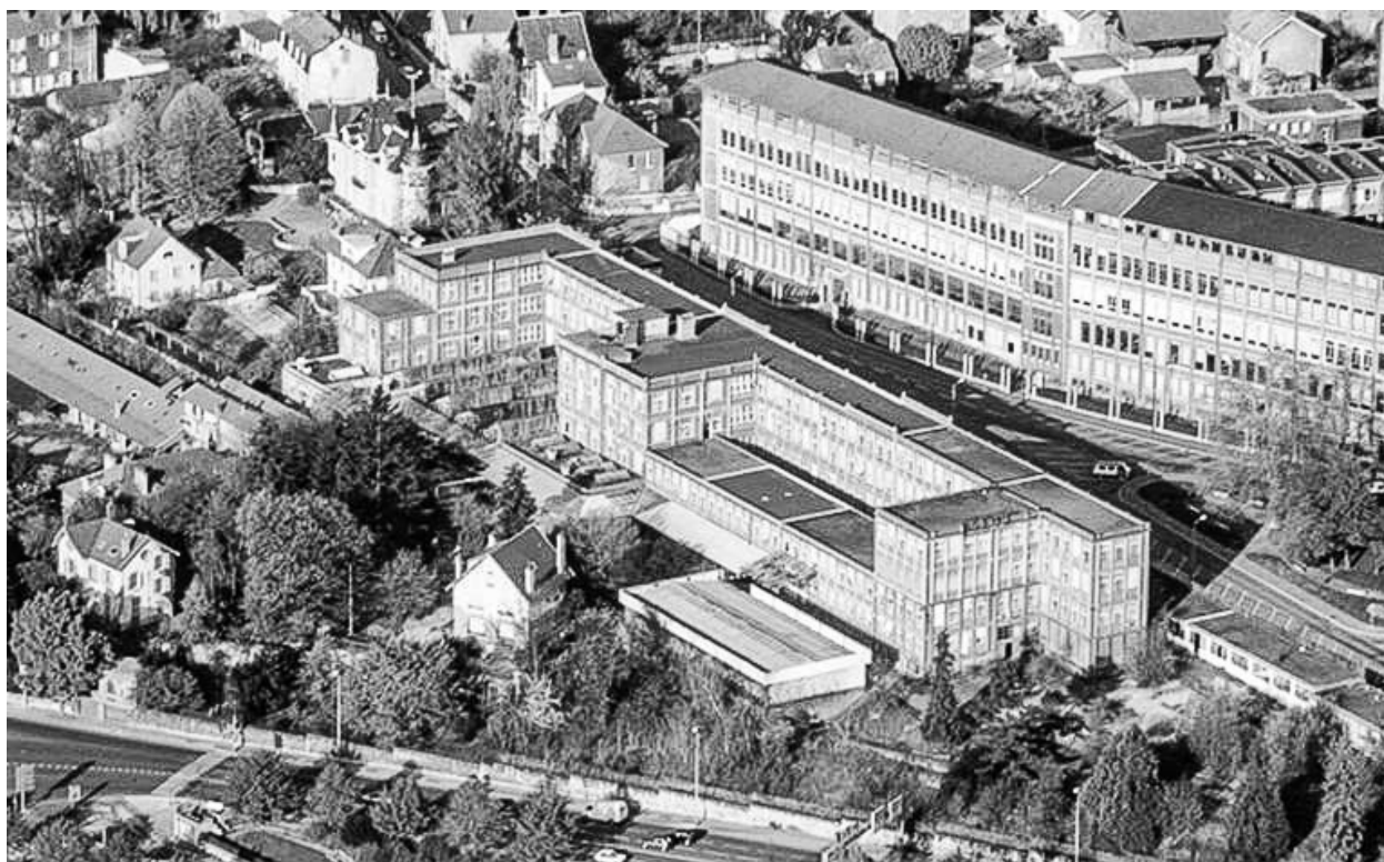
Vue aérienne de l'usine, depuis l'est.
