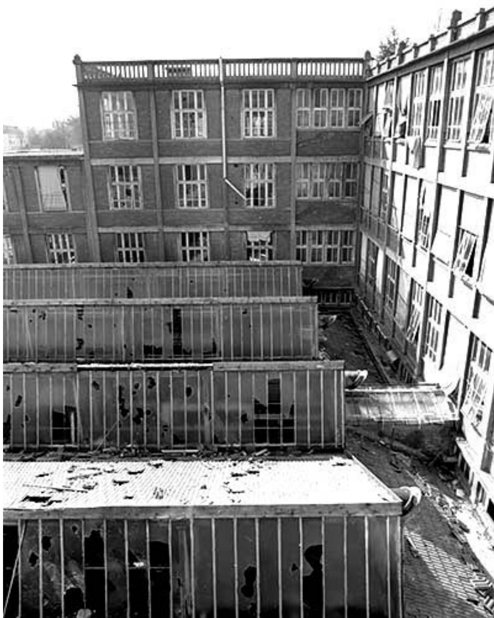
Bâtiment (2a) et sheds du bâtiment (3).
