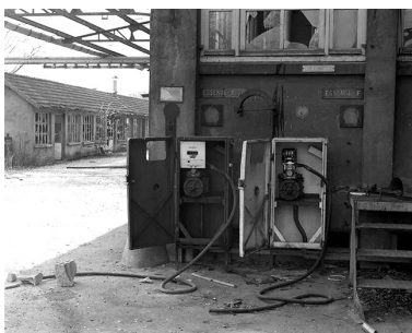
Pompes à essence. Phot. Yves Sancey IVR43_19932500026X
