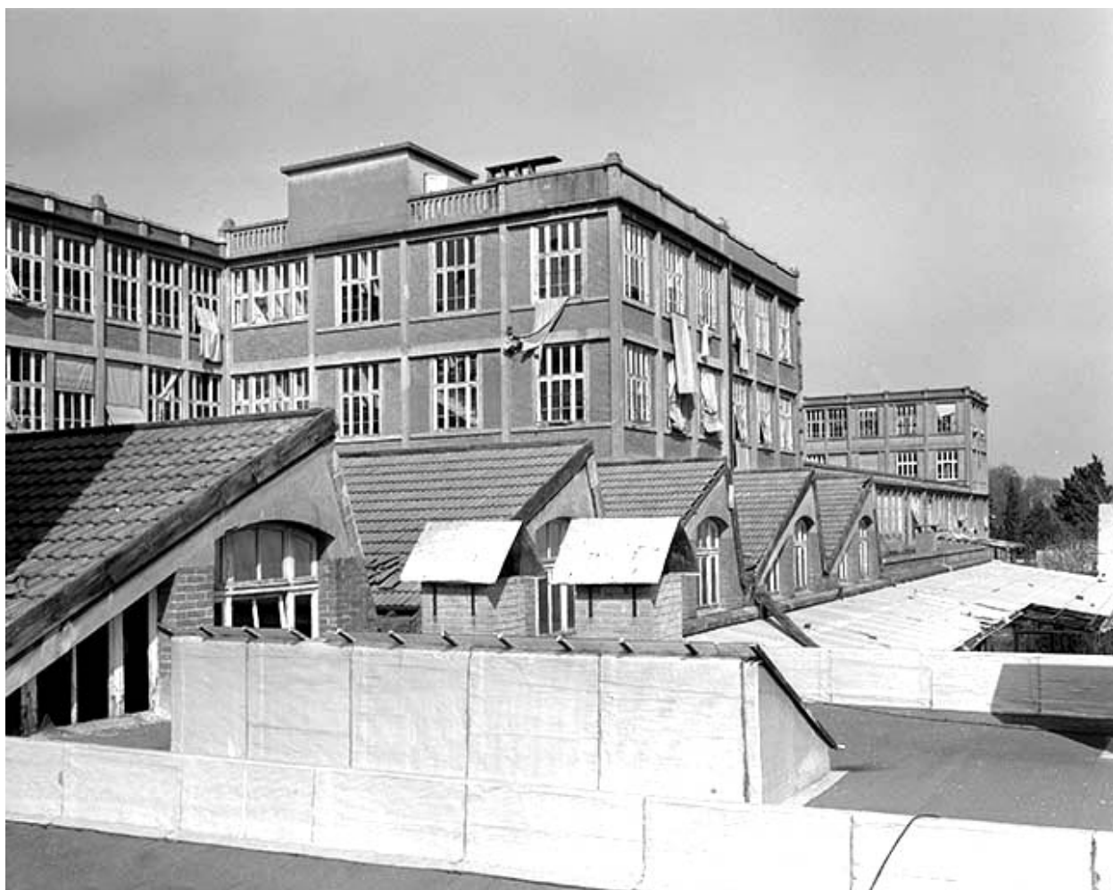
Façade postérieure et sheds.
