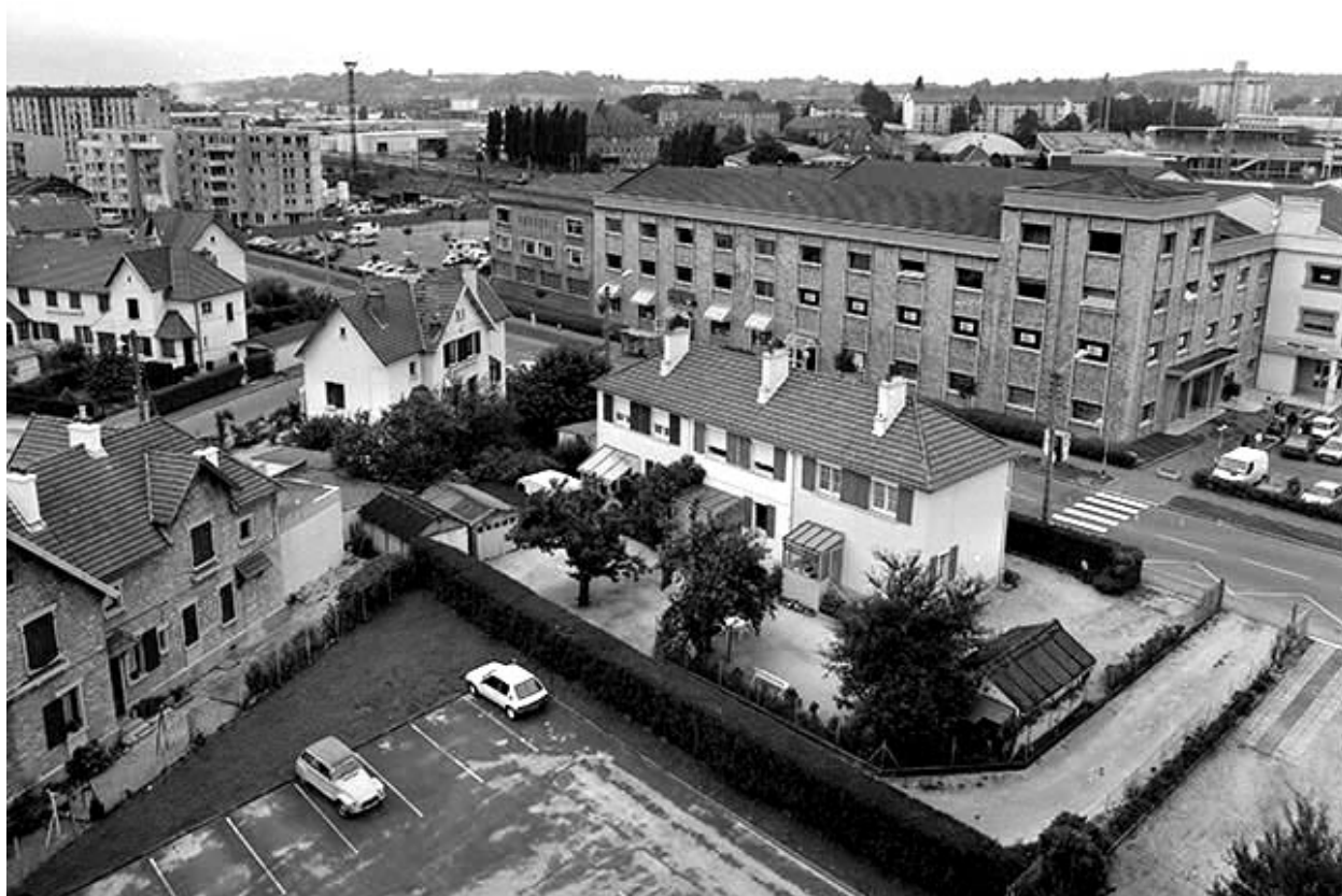
Vue d'ensemble de la cité ouvrière : ouest.
