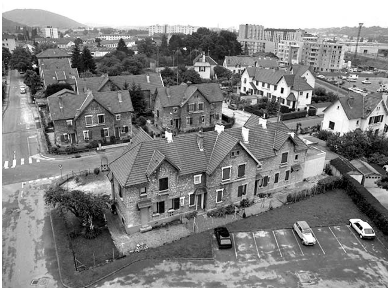
Vue d'ensemble de la cité ouvrière : sud-ouest.
