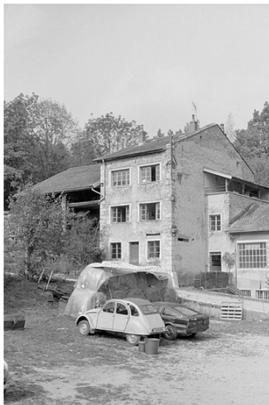
Hangar et atelier de fabrication (B). Phot. Laurent Poupard IVR43_19913901101Z
