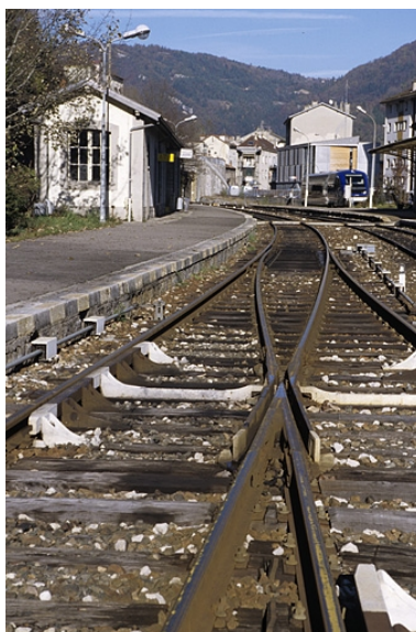
Appareil de la voie 2 (B), depuis la pointe de coeur au sud (côté La Cluse). Phot. Yves Sancey
