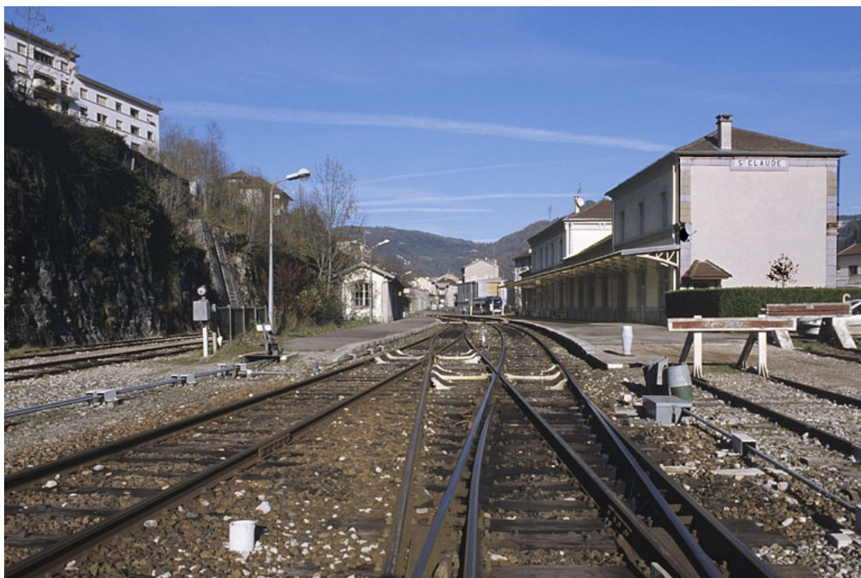
Vue d'ensemble des voies depuis le côté La Cluse, au sud.
