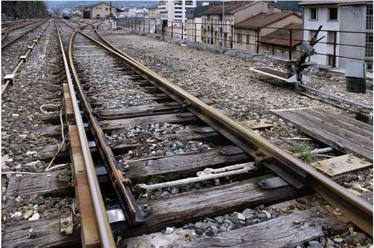
Aiguilles sur la voie 1 (A), vers la remise ferroviaire. Raccordement des voies 3, 5, 7 et 7 bis sur la voie 1. Rampe de réchauffage au gaz à gauche, levier de manoeuvre enclenché à droite.
