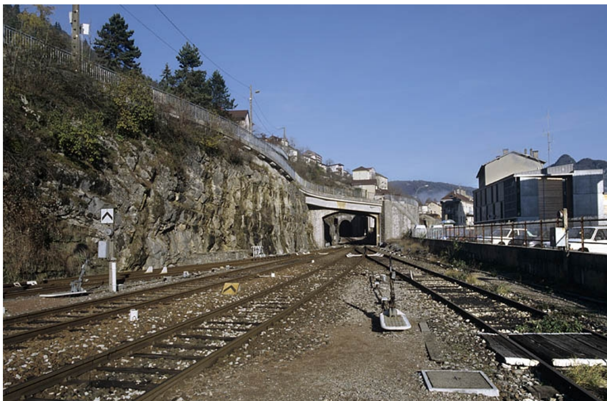
Faisceau de voies vers l'entrée côté Andelot-en-Montagne.
