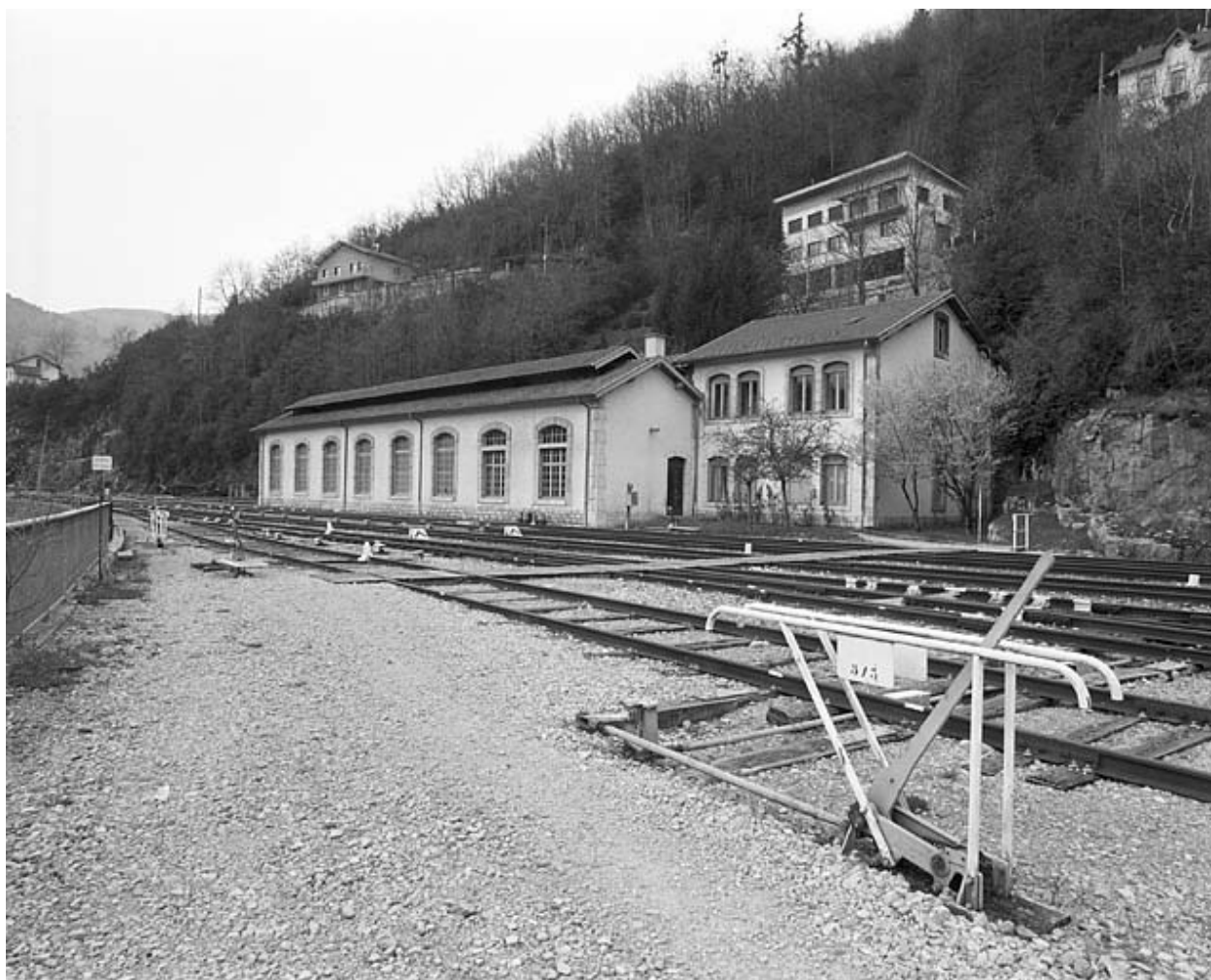
Faisceau des voies vers le foyer des roulants et la remise ferroviaire, depuis le côté Andelot-en-Montagne. Au premier plan, sur le levier de manoeuvre non enclenché, la plaque donne le numéro des voies desservies par l'appareil.
