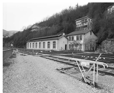
Faisceau des voies vers le foyer des roulants et la remise ferroviaire, depuis le côté Andelot-en-Montagne. Au premier plan, sur le levier de manoeuvre non enclenché, la plaque donne le numéro des voies desservies par l'appareil. Phot. Yves Sancey IVR43_20053900794X
