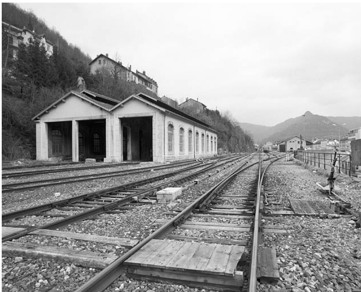
Faisceau des voies vers la remise ferroviaire, depuis le côté La Cluse. L'extrémité des aiguilles est visible pour les deux voies.
