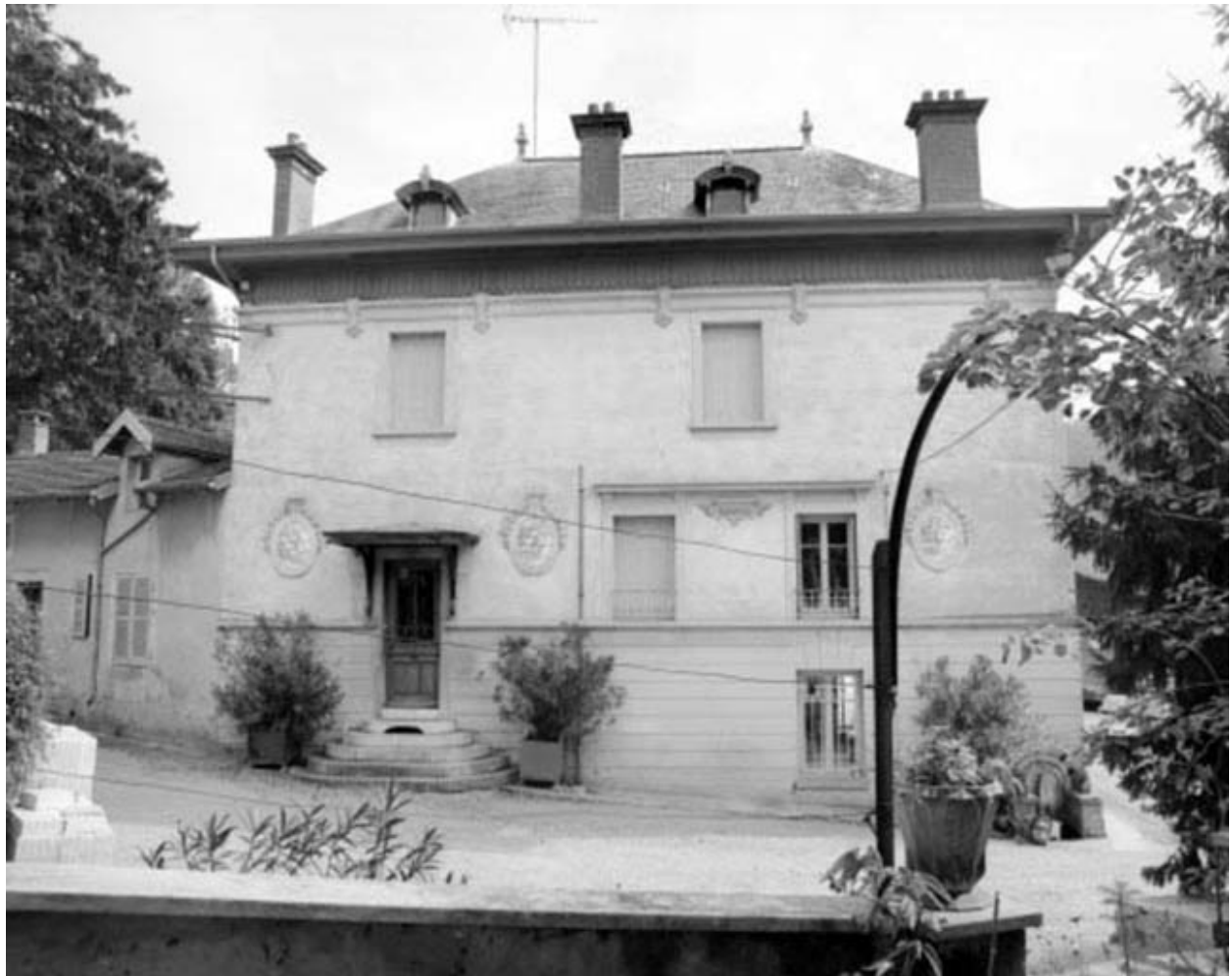
Façade latérale gauche du bureau.
