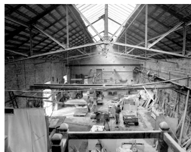
Intérieur de l'atelier central (débitage-polissage). Phot. Yves Sancey IVR43_19933900178X
