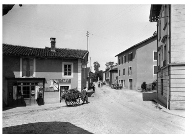
Café, logement patronal et logement d'ouvriers. Phot. Jérôme Mongreville, Phot. Jules Manias IVR43_19963900184X
