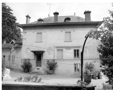
Façade latérale gauche du bureau. Phot. Yves Sancey IVR43_19933900187X
