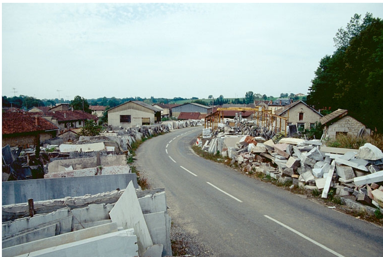
Vue d'ensemble depuis la route, à l'est.
