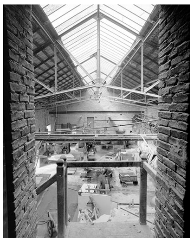
Intérieur de l'atelier central (débitage-polissage). Phot. Yves Sancey IVR43_19933900179X
