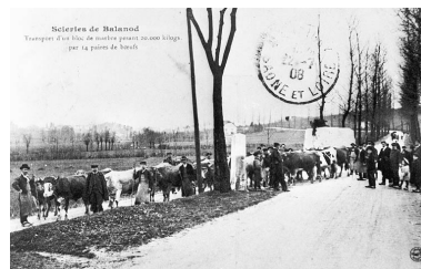
Scieries de Balanod. Transport d'un bloc de marbre pesant 20.000 kilogs. par 14 paires de boeufs. Phot. Yves Sancey, Autr. Méral IVR43_19973901599X
