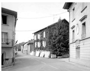
Logement patronal et logement d'ouvriers. Phot. Yves Sancey IVR43_19933900193X
