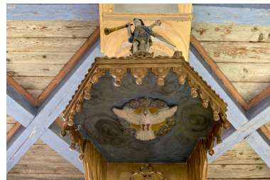
Détail de la chaire. Phot. Sonia Dourlot IVR43_20157001184NUC4A
