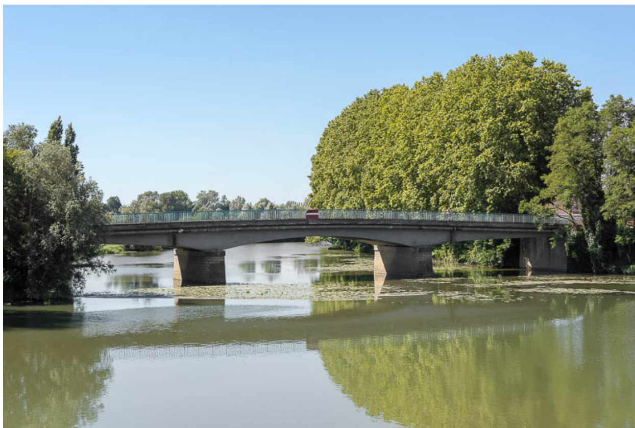
Vue d'ensemble du pont.
