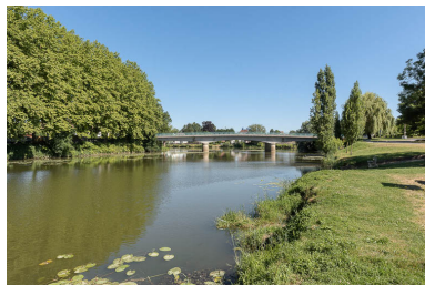
Vue générale du pont et du site. Phot. Pierre-Marie Barbe-Richaud IVR26_20187100280NUC4A
