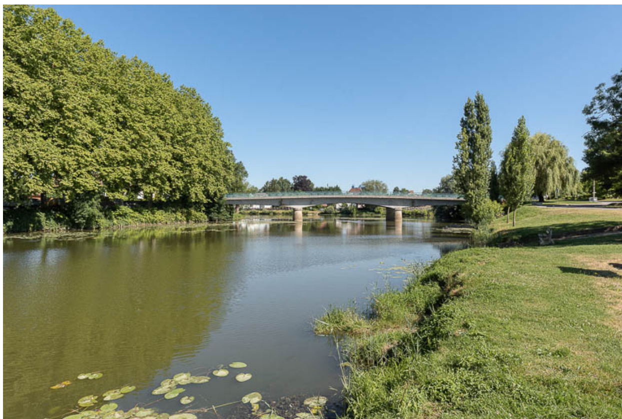
Vue générale du pont et du site.
