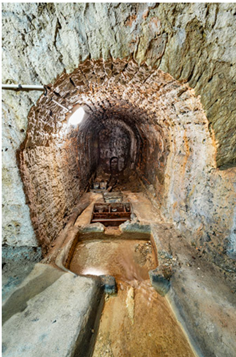
Galerie maçonnerie renfermant les bassins de division. Vue depuis l'amont.
