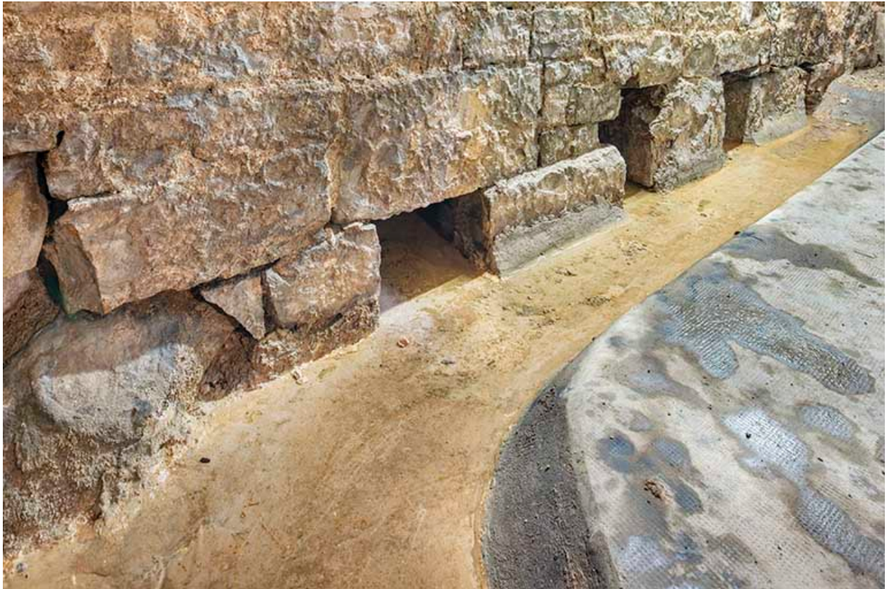
Rigole de captage des filets d'eau.
