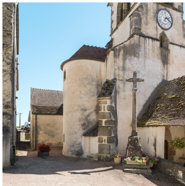
Tourelle d'escalier. Phot. Pierre-Marie Barbe-Richaud IVR26_20167100058NUC2A
