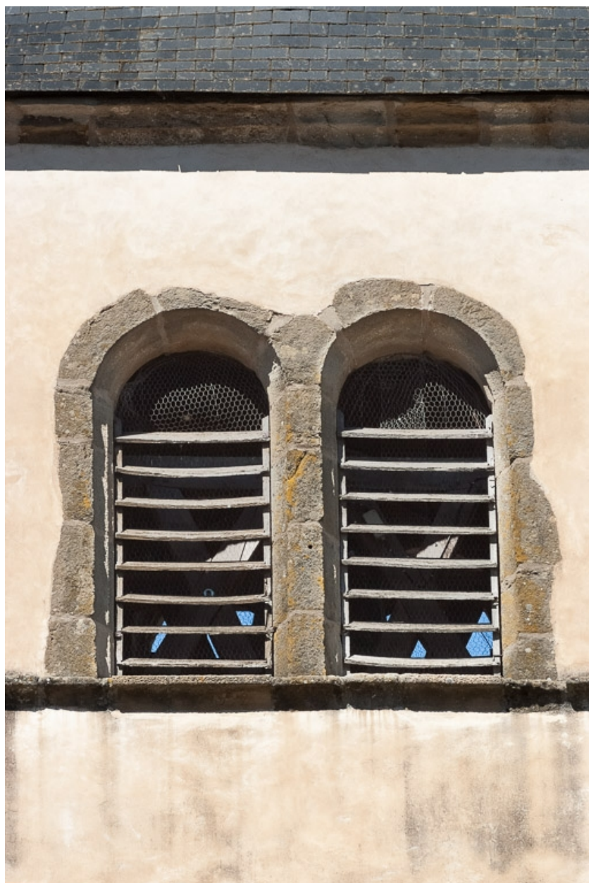
Clocher, détail de deux baies jumelées.
