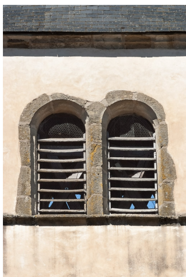
Clocher, détail de deux baies jumelées. Phot. Pierre-Marie Barbe-Richaud IVR26_20167100075NUC2A
