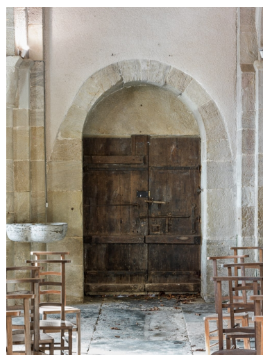
Porte d'entrée, côté intérieur. Phot. Pierre-Marie Barbe-Richaud IVR26_20177100111NUC2A
