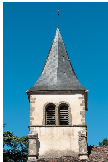
Elévation sud du clocher. Phot. Pierre-Marie Barbe-Richaud IVR26_20167100074NUC2A
