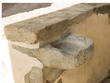
Bénitier du porche. Phot. Pierre-Marie Barbe-Richaud IVR26_20177100107NUC2A
