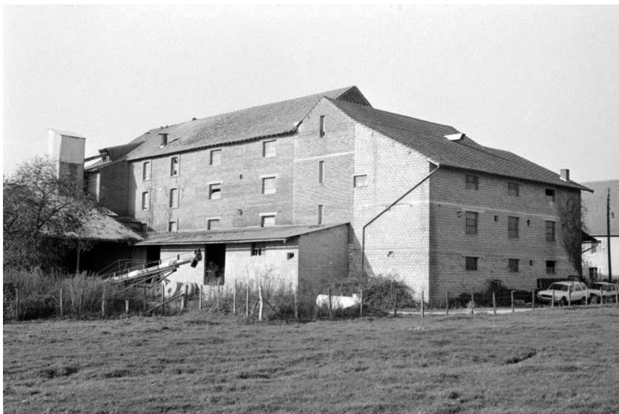
Façades postérieure et latérale gauche.
