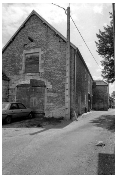
Pignon de l'habitation avec remise. Phot. Bernard Lardière IVR43_19817000504Z
