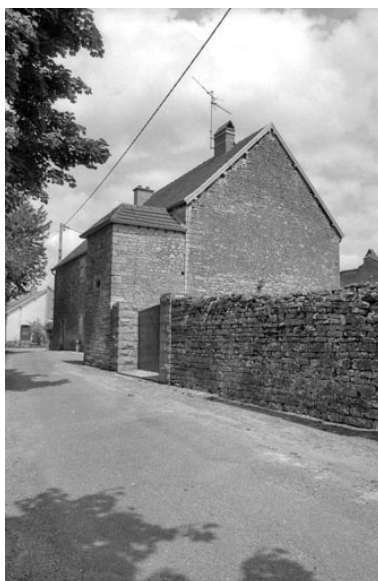
Façade latérale droite Phot. Bernard Lardière IVR43_19817000502Z
