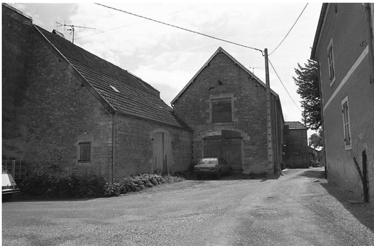
Façade latérale gauche.
