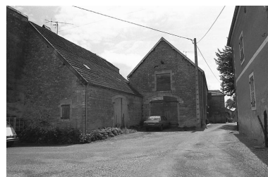
Façade latérale gauche. Phot. Bernard Lardière IVR43_19817000501Z
