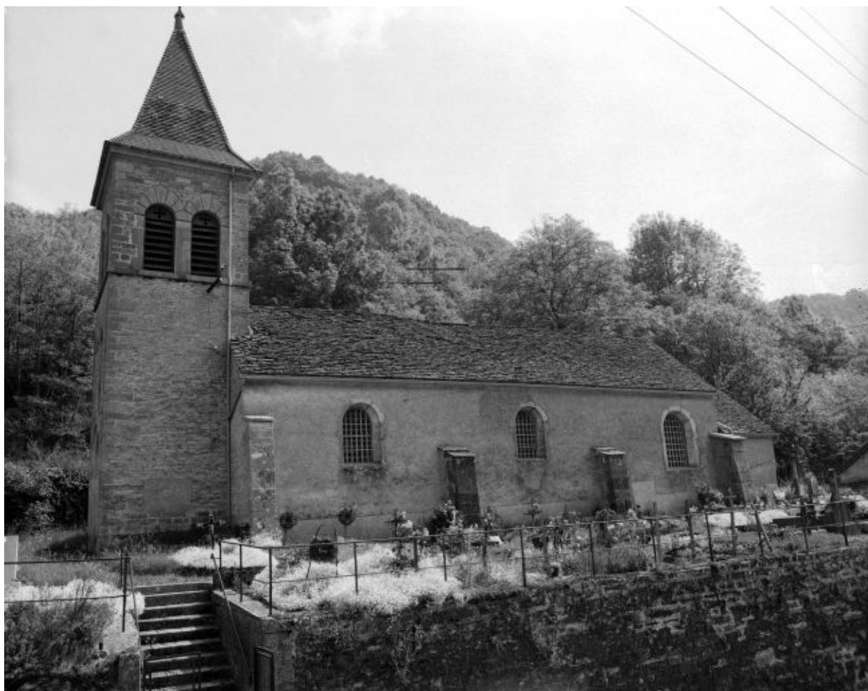
Façade latérale droite.
