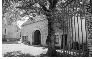
Dépendance à droite dans la cour. Phot. Bernard Lardière IVR43_19817000186Z
