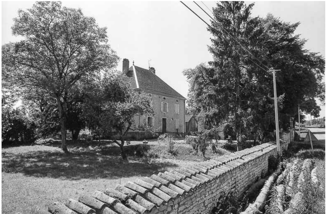
Vue d'ensemble depuis la rue.
