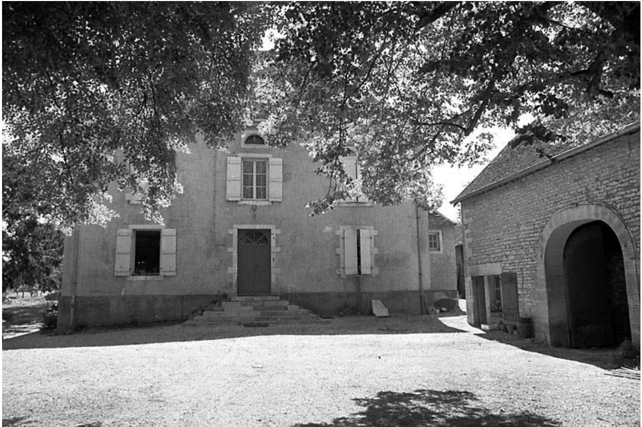
Vue des bâtiments depuis la cour.
