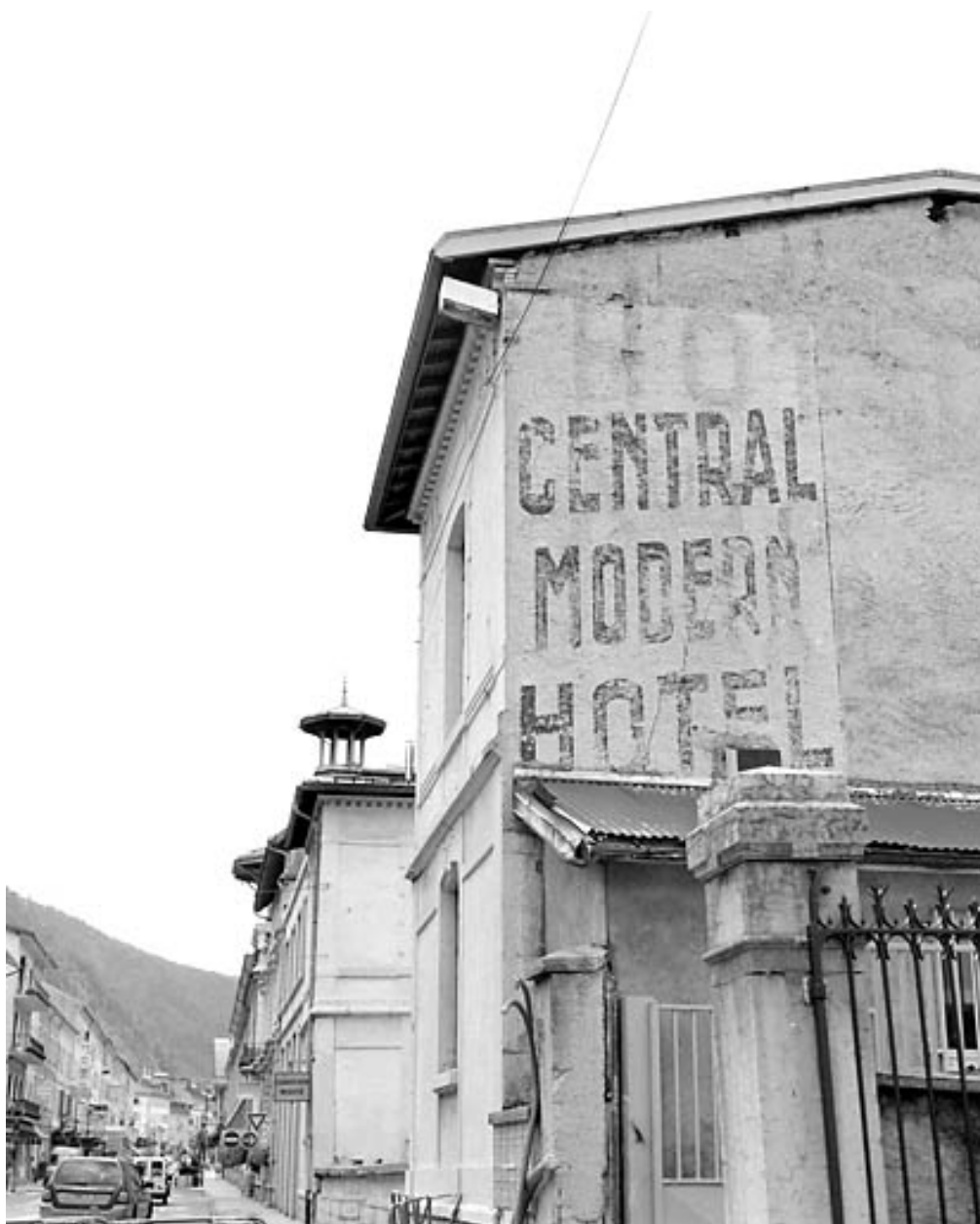
Enseigne peinte sur l'élévation latérale droite.
