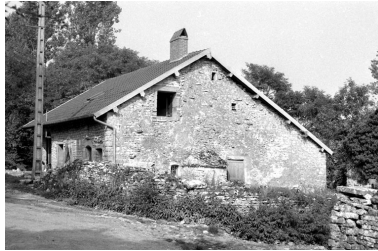
Façade latérale droite. Phot. Bernard Lardière IVR43_19797000102Z
