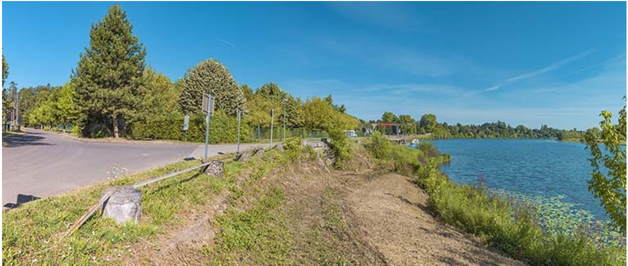
Perrés en aval du port de Gergy.
