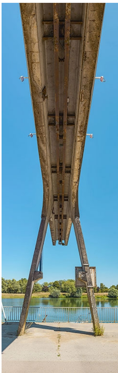
Portique de déchargement avec poulie. Phot. Thierry Kuntz IVR26_20207100308NUC4A
