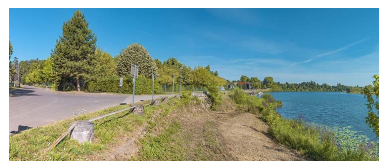
Perrés en aval du port de Gergy. Phot. Thierry Kuntz IVR26_20207100313NUC4A
