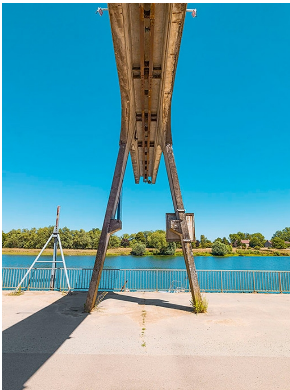
Portique de déchargement avec poulie.
