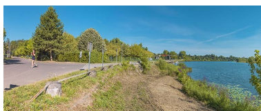
Perrés en aval du port de Gergy. Phot. Thierry Kuntz IVR26_20207100312NUC4A
