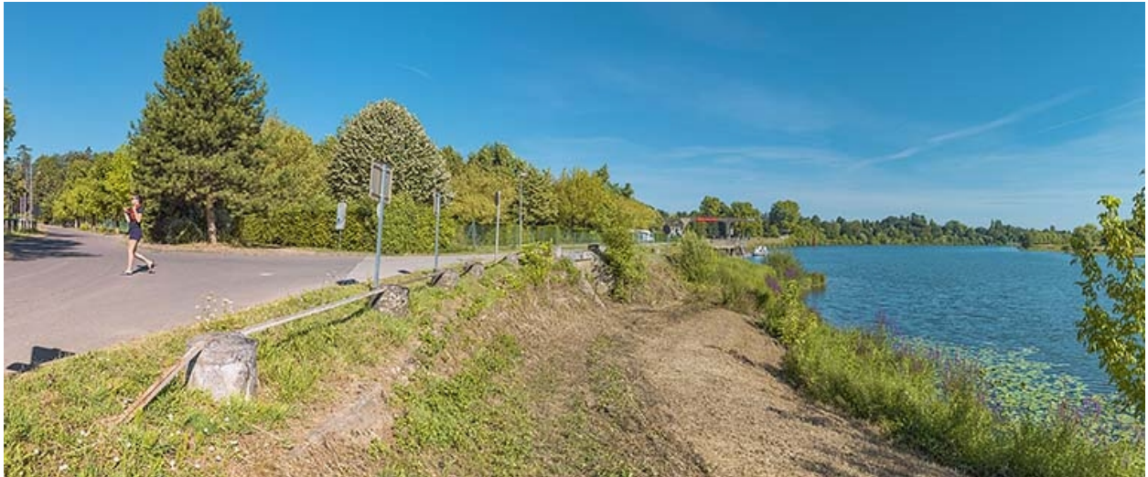
Perrés en aval du port de Gergy.
