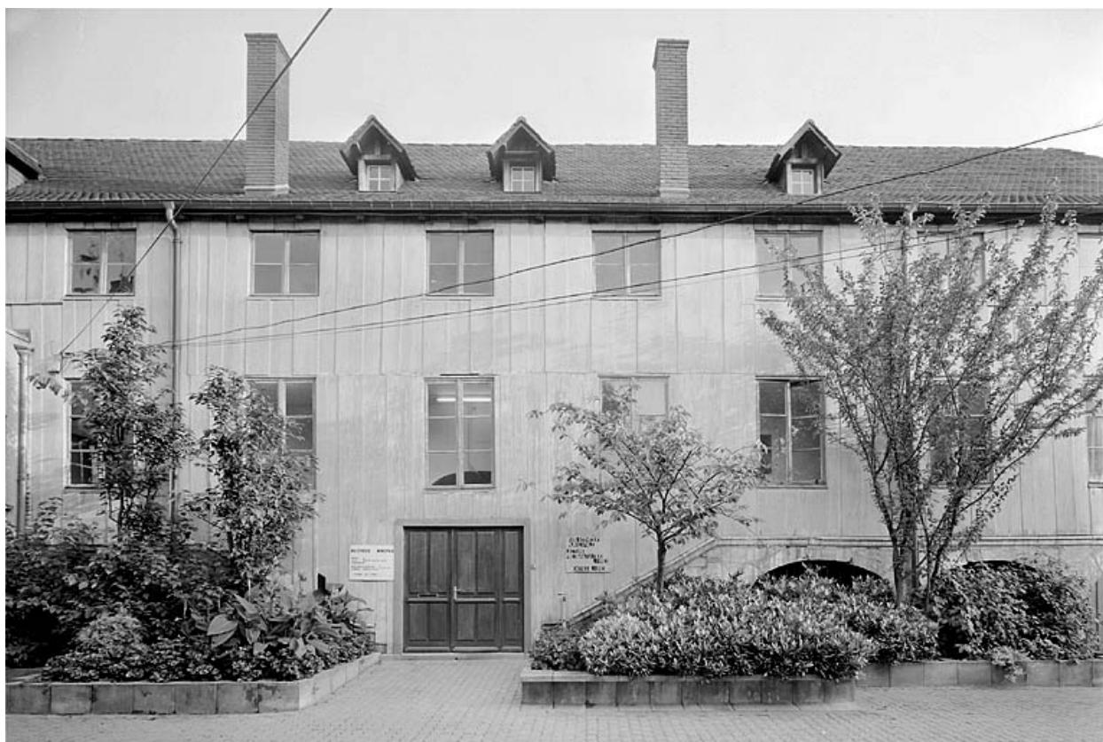
Façade sur cour.
