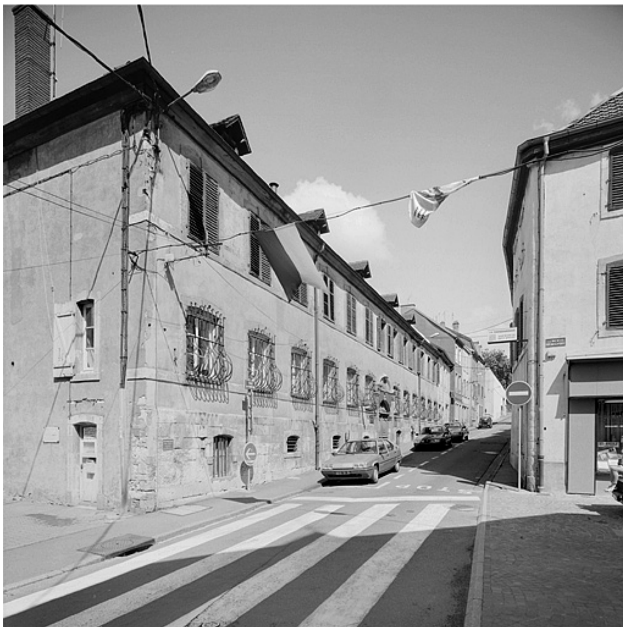
Façade sur la rue du Château.
