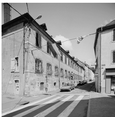
Façade sur la rue du Château. Phot. Jérôme Mongreville IVR43_19882500161V
