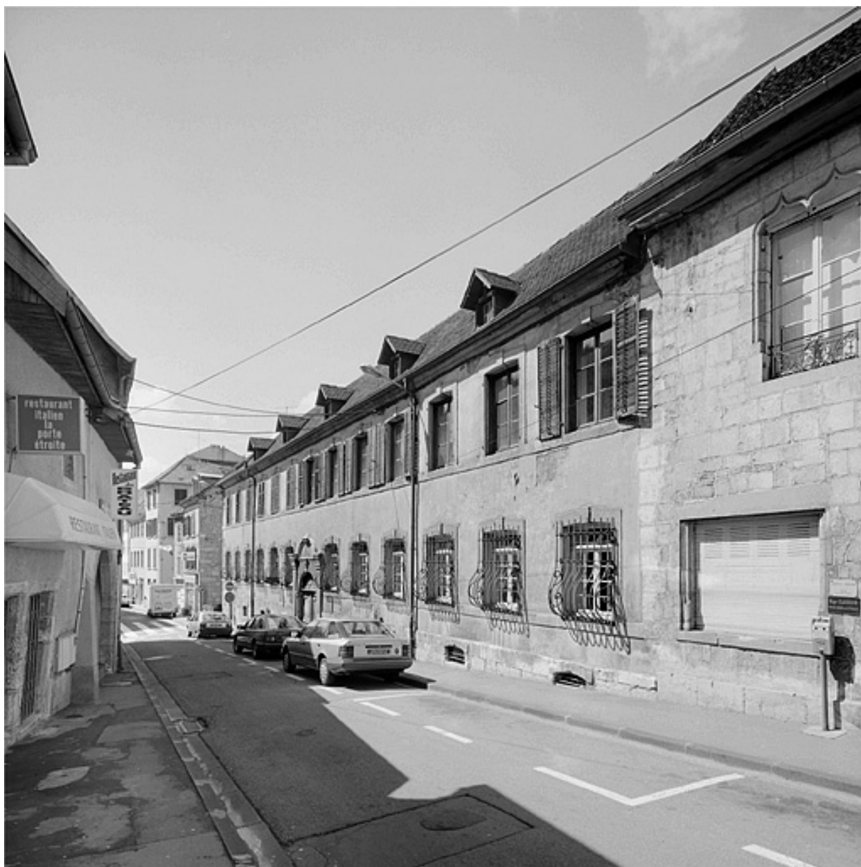
Façade sur la rue du Château.
