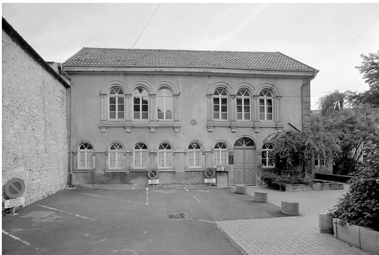
Bâtiment des Bains. Façade sur cour.
