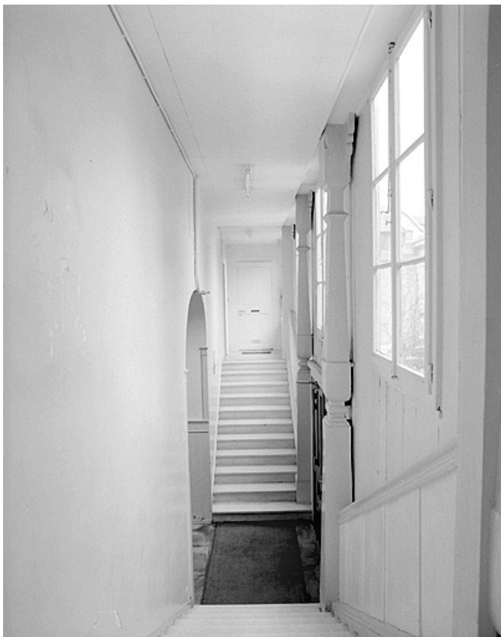
Escalier de la galerie de distribution.
