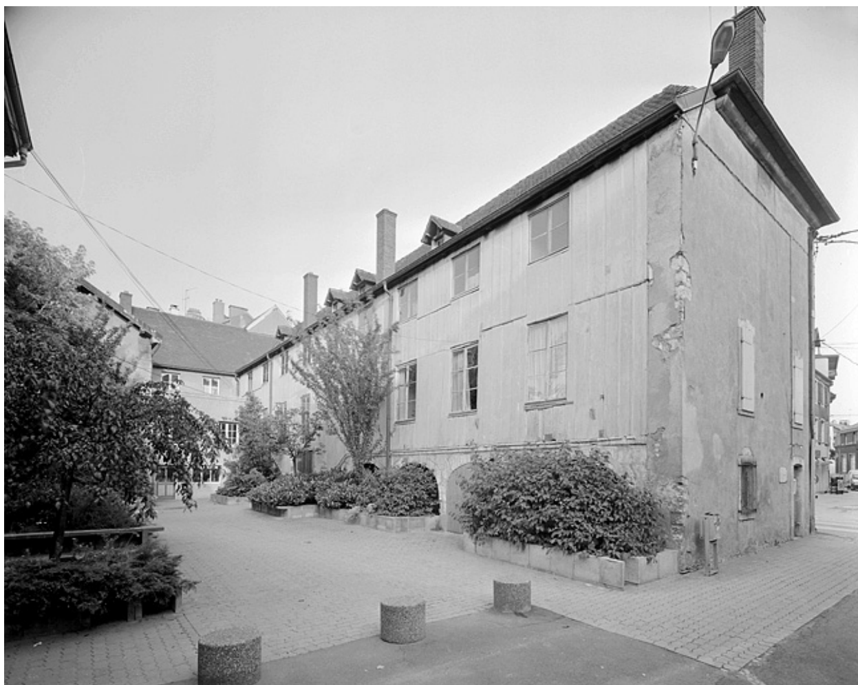
Façade sur cour.
