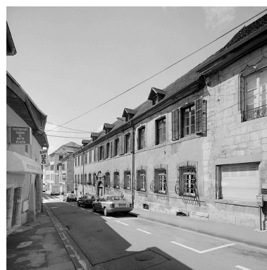
Façade sur la rue du Château. Phot. Jérôme Mongreville IVR43_19882500162V
