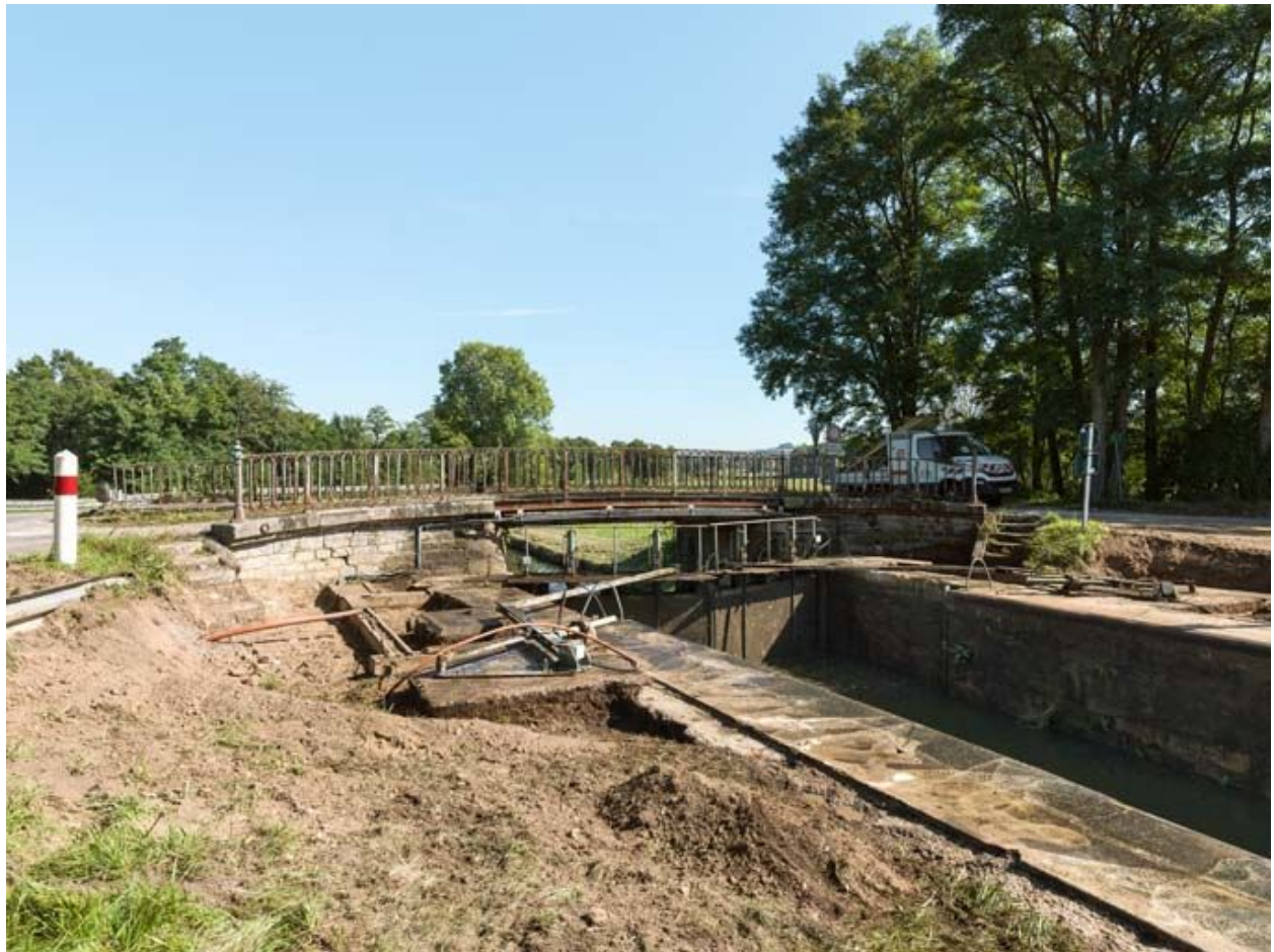
Vue d'ensemble du site d'écluse.
