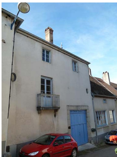
Façade sur la rue du Grand Mont Phot. Sabrina Dalibard IVR43_20137000831NUC2A
