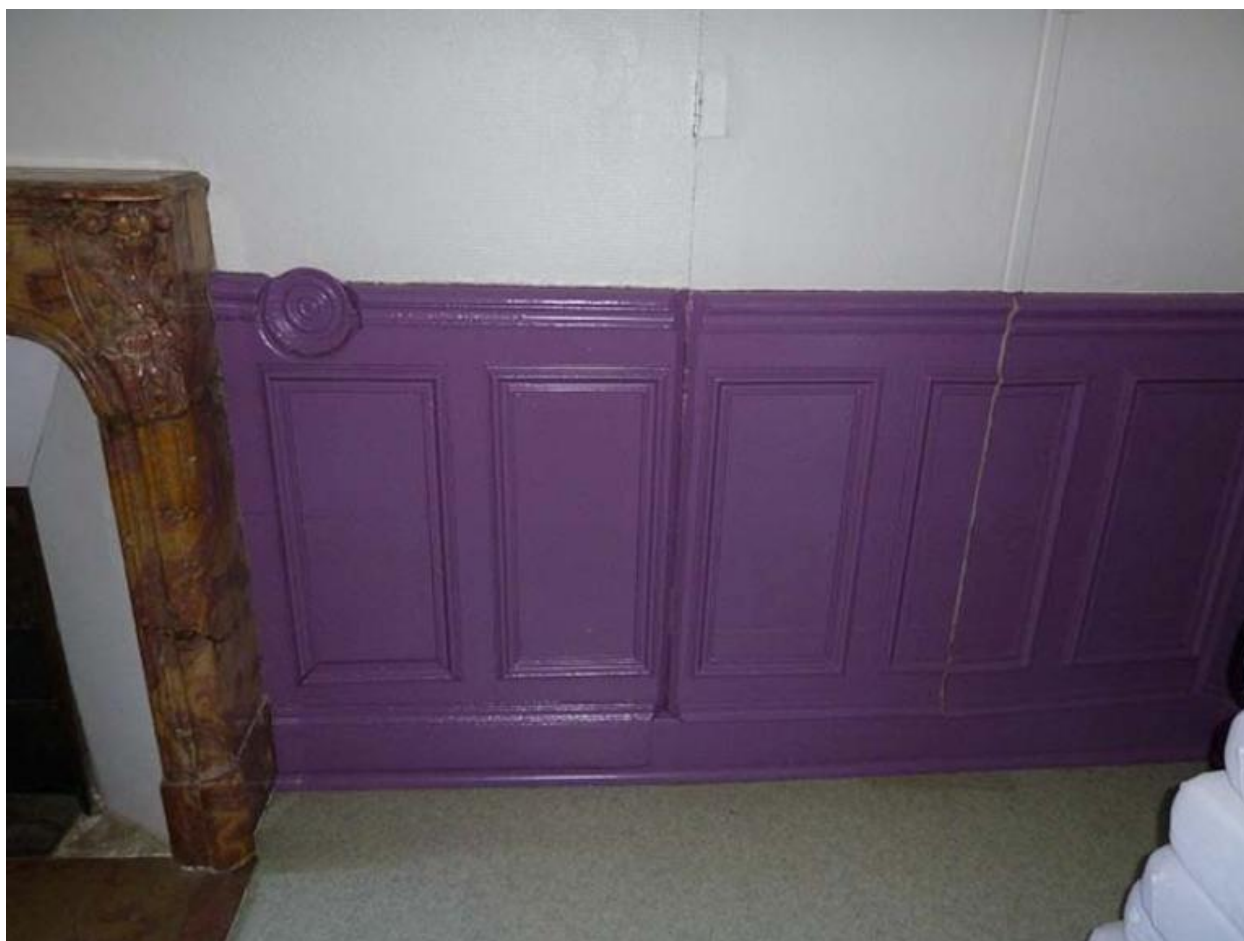
Boiseries de la partie sud-ouest
