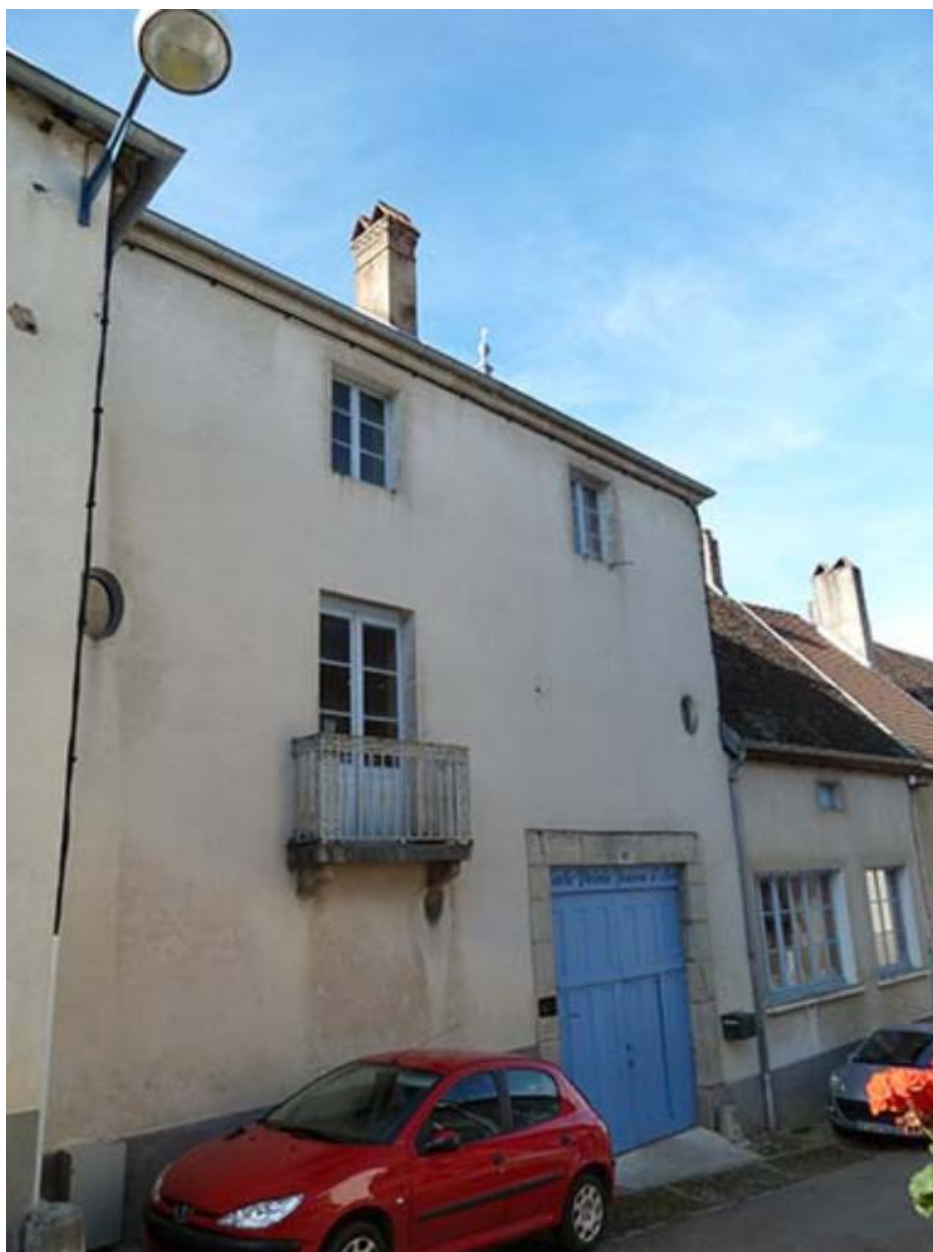
Façade sur la rue du Grand Mont
