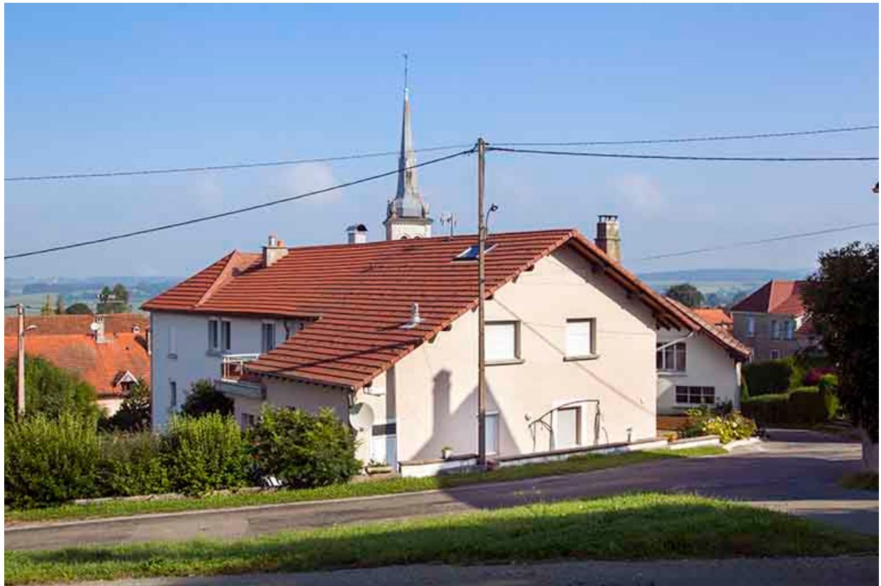
Façades postérieure et latérale droite.
