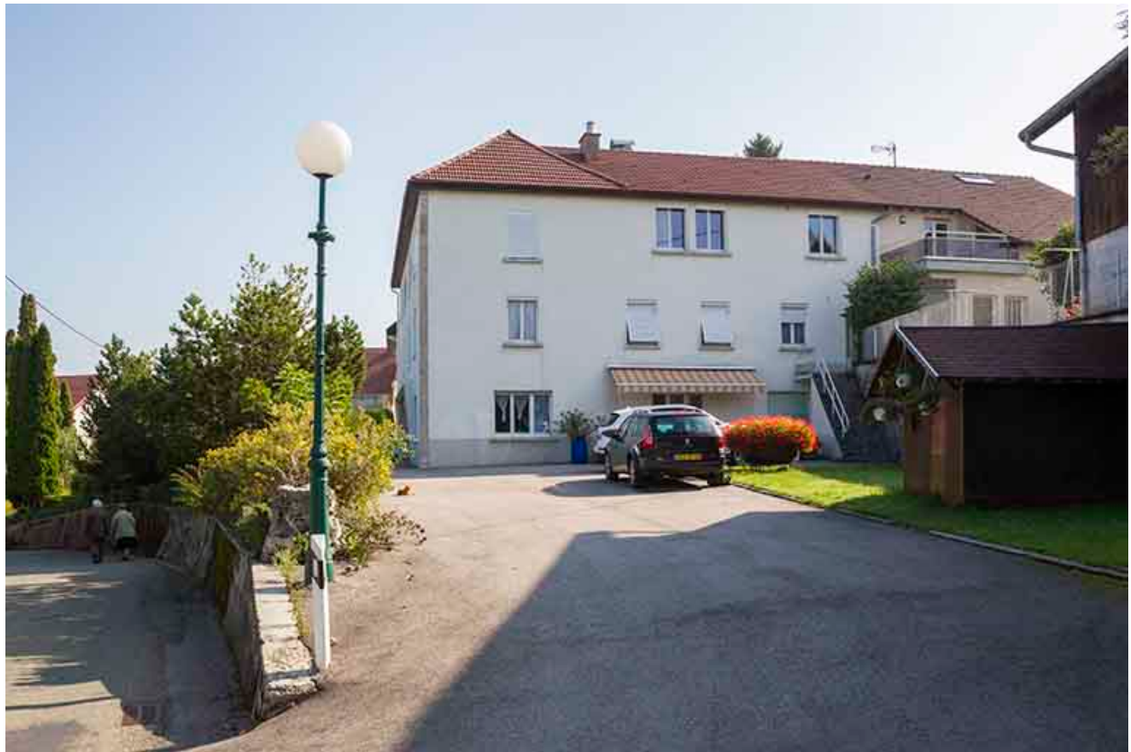
Façade latérale droite.
