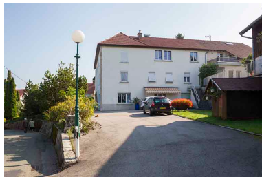
Façade latérale droite. Phot. Yves Sancey IVR43_20132501114NUC2A
