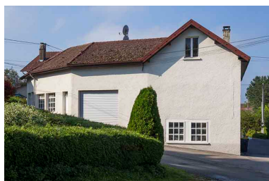
Façade latérale gauche. Phot. Yves Sancey IVR43_20132501112NUC2A
