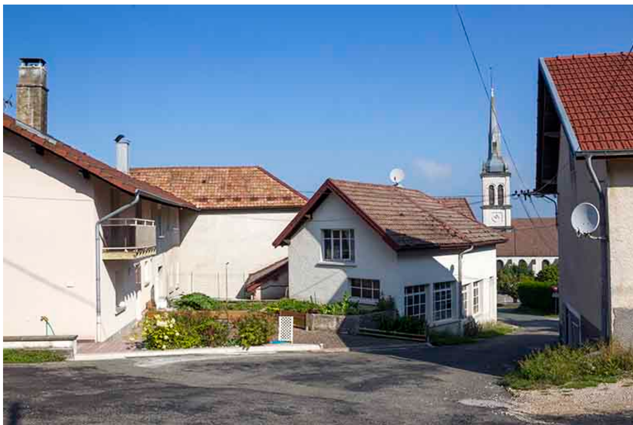
Façades postérieure et latérale gauche.
