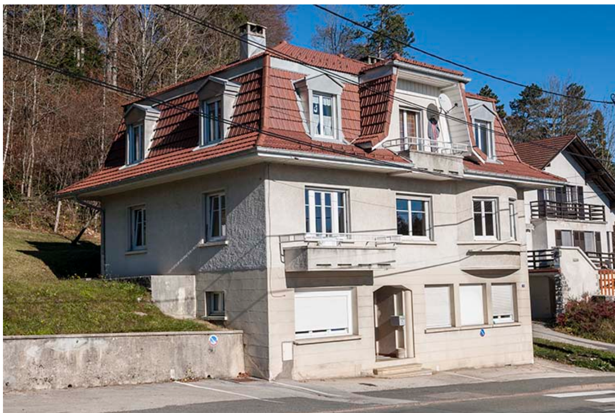
Façades antérieure et latérale gauche.
