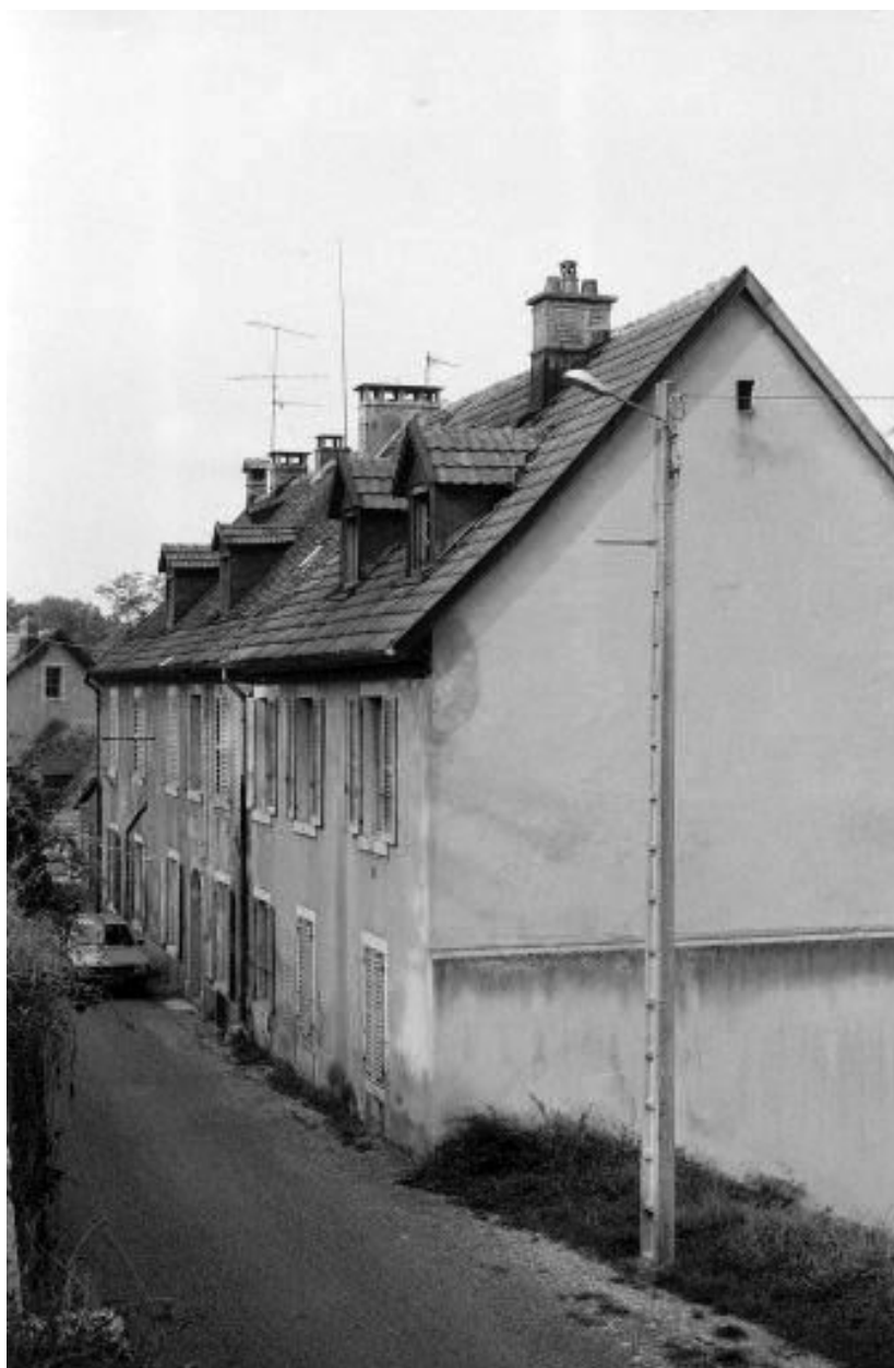
Façades antérieure et latérale droite.
