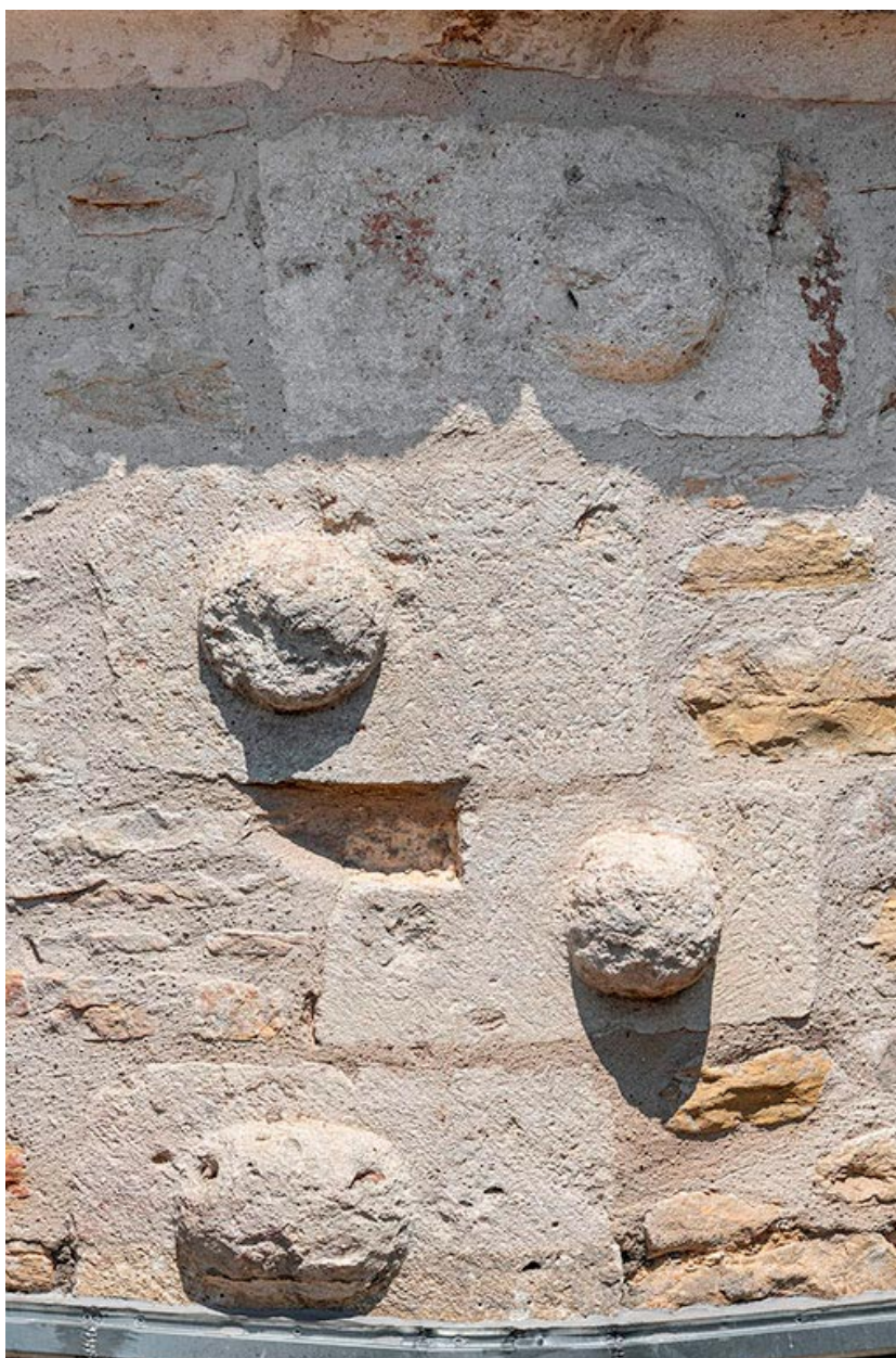
Bossage de la tour des Cordeliers.
