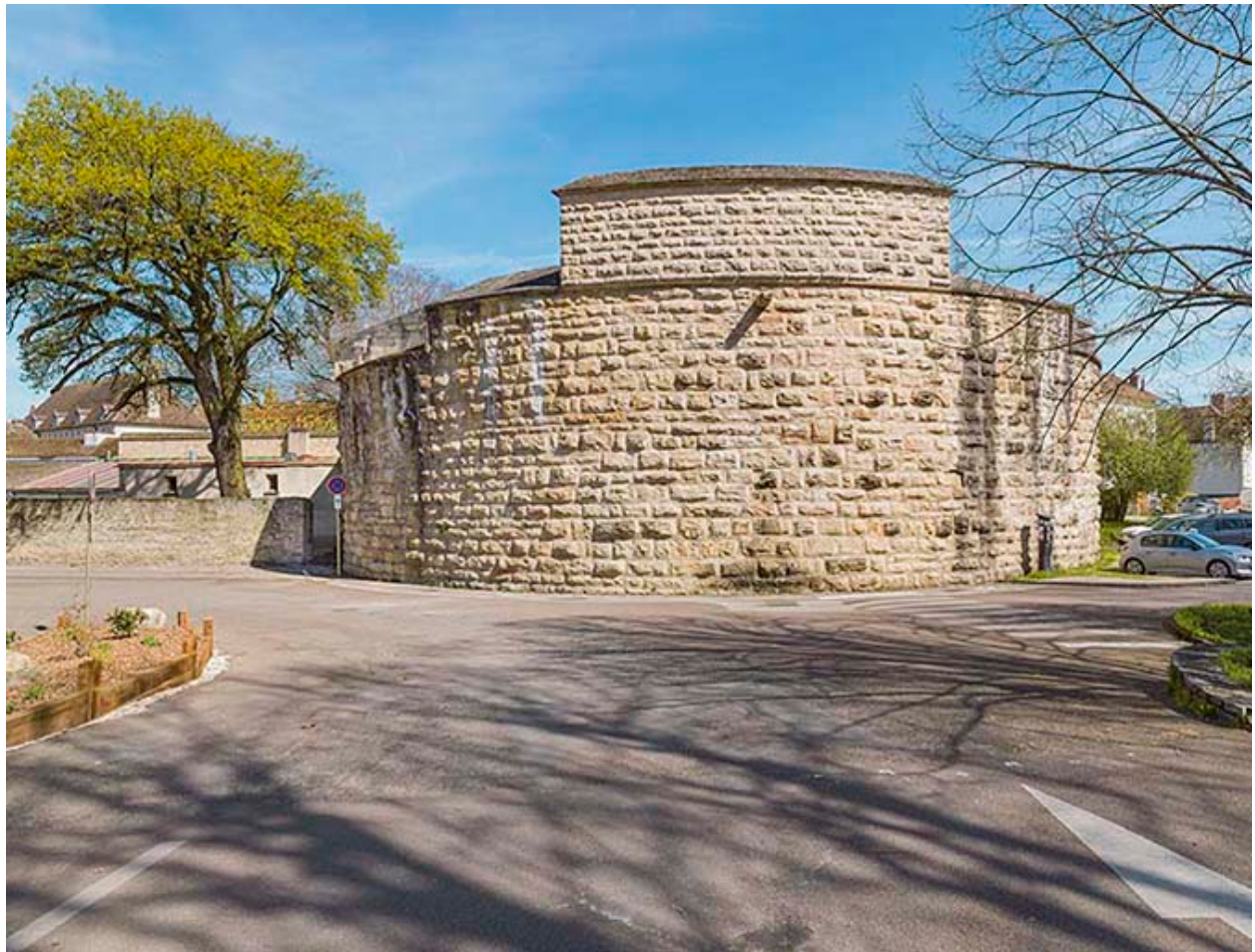
Vue d'ensemble depuis le boulevard Saint-Jacques.
