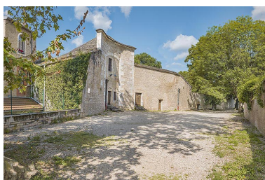
Le rempart et la gorge de la tour. Phot. Thierry Kuntz IVR26_20242100281NUC4A
