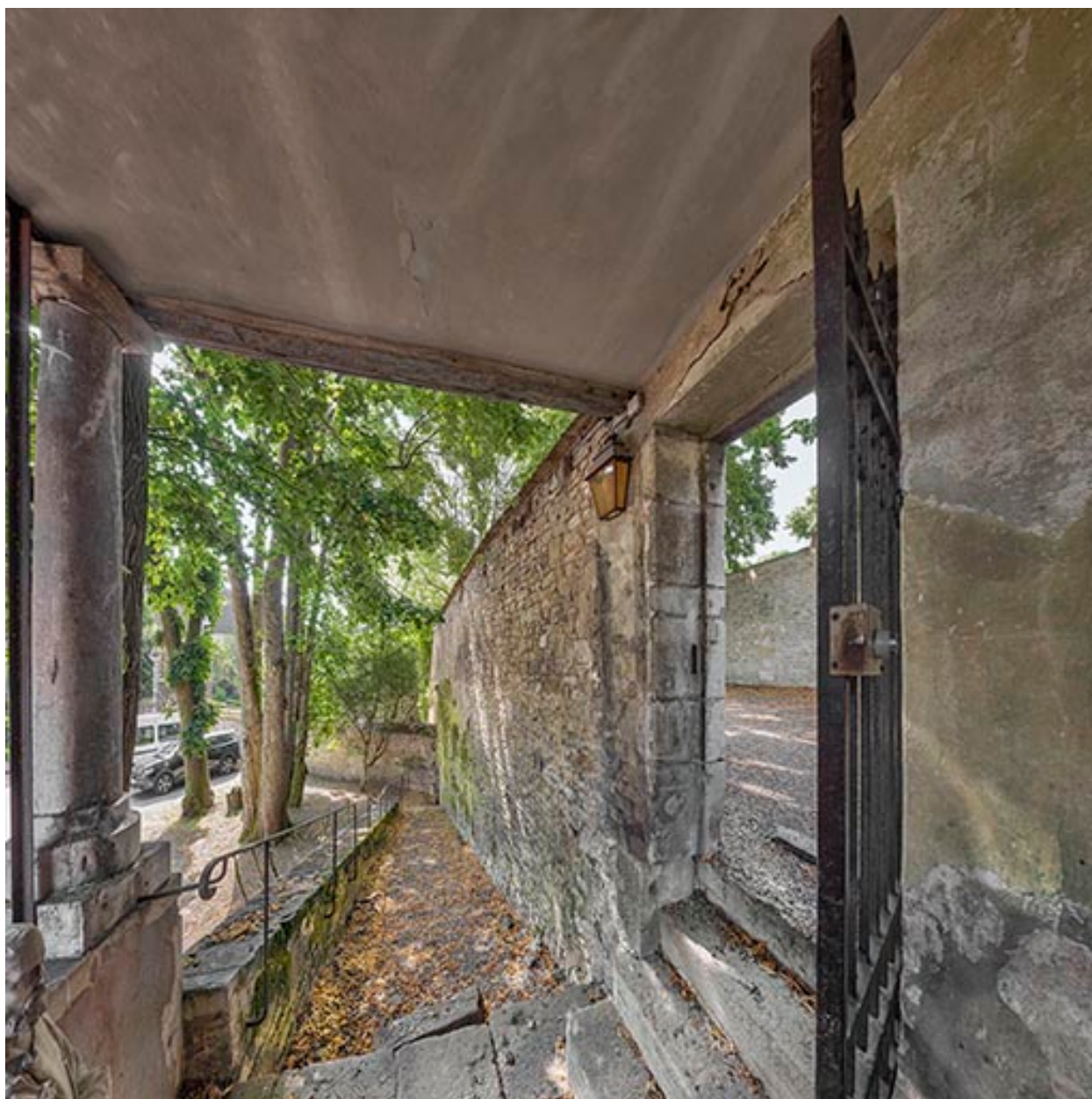
Passage reliant le rempart à l'hôtel-Dieu.
