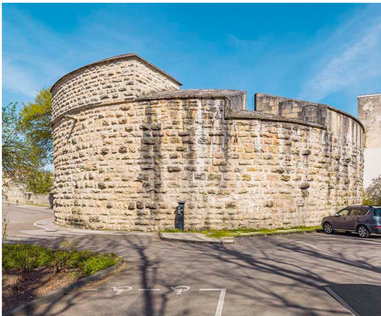
La tour et son parapet crénelé.
