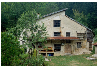
Façade antérieure. Phot. Laurent Poupard IVR43_19903901234ZA
