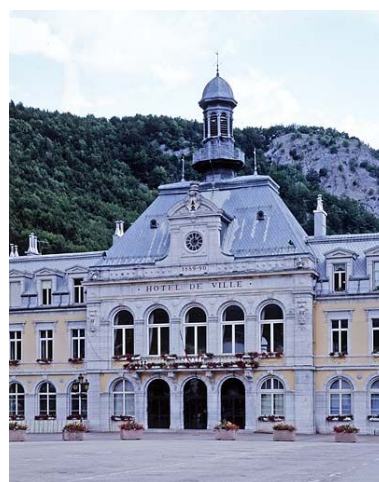
Elévation antérieure : pavillon central. Phot. Jérôme Mongreville IVR43_20003900372VA
