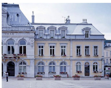
Elévation antérieure : partie droite. Phot. Jérôme Mongreville IVR43_20003900370VA
