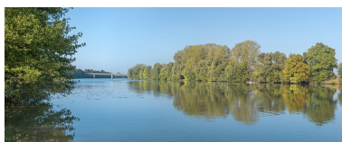
Vue d'amont. Phot. Thierry Kuntz IVR26_20162101401NUC4A
