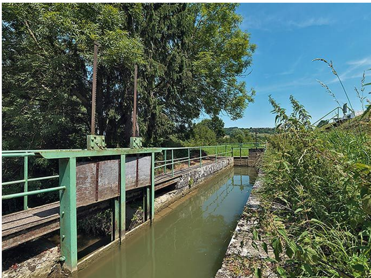
Vannes de régulation sur la rigole.
