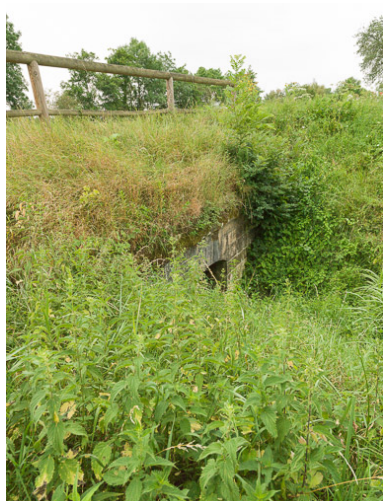
Vue de l'aqueduc. Phot. Pierre-Marie Barbe-Richaud IVR26_20175800183NUC2A
