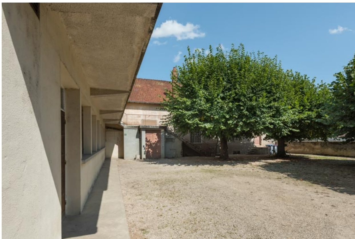
Cinéma : façade latérale droite.
