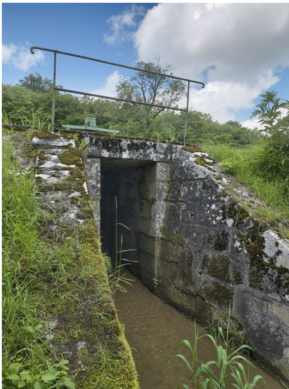
Déversoir rive gauche : sortie du déversoir.
