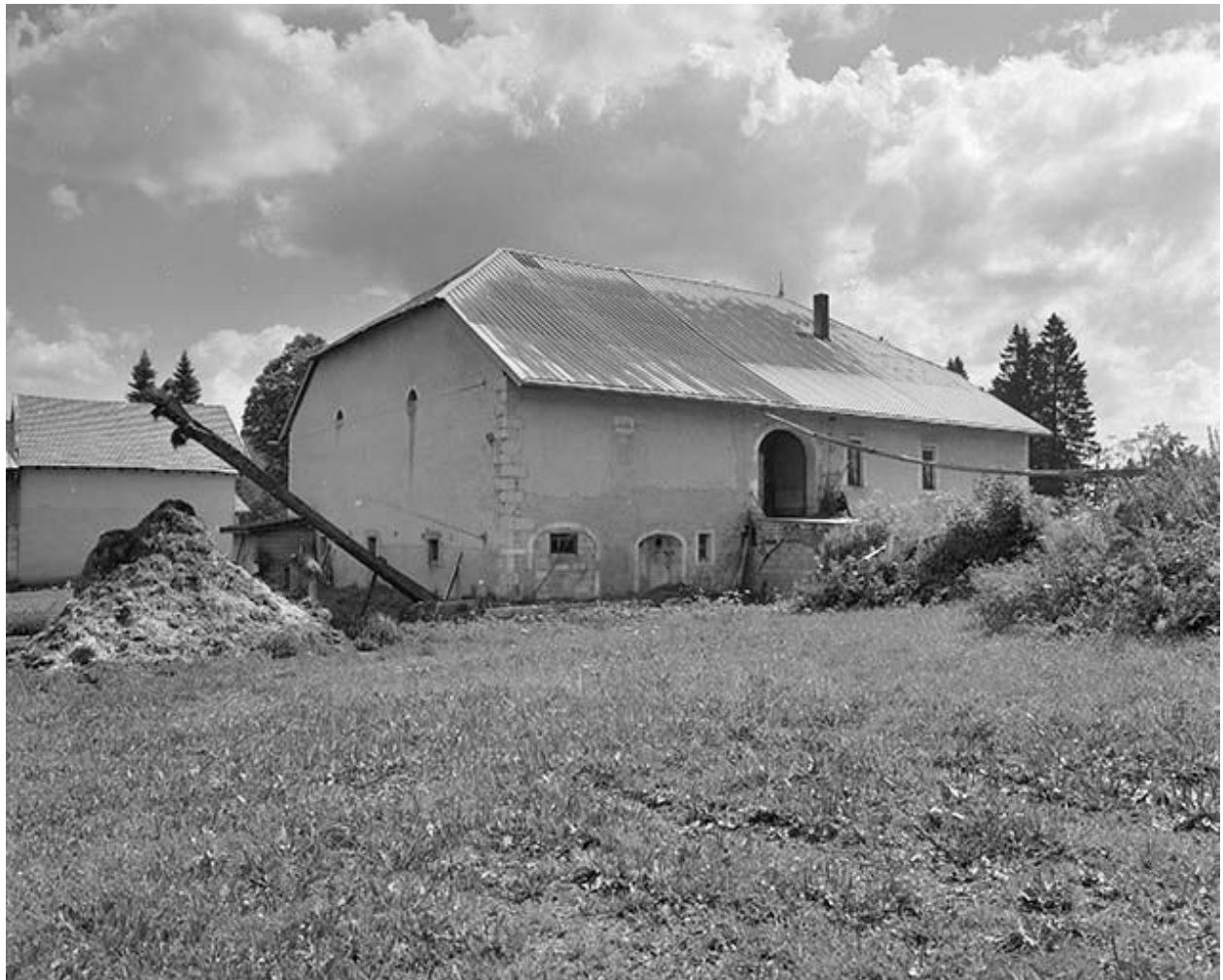
Façade postérieure et face droite.
