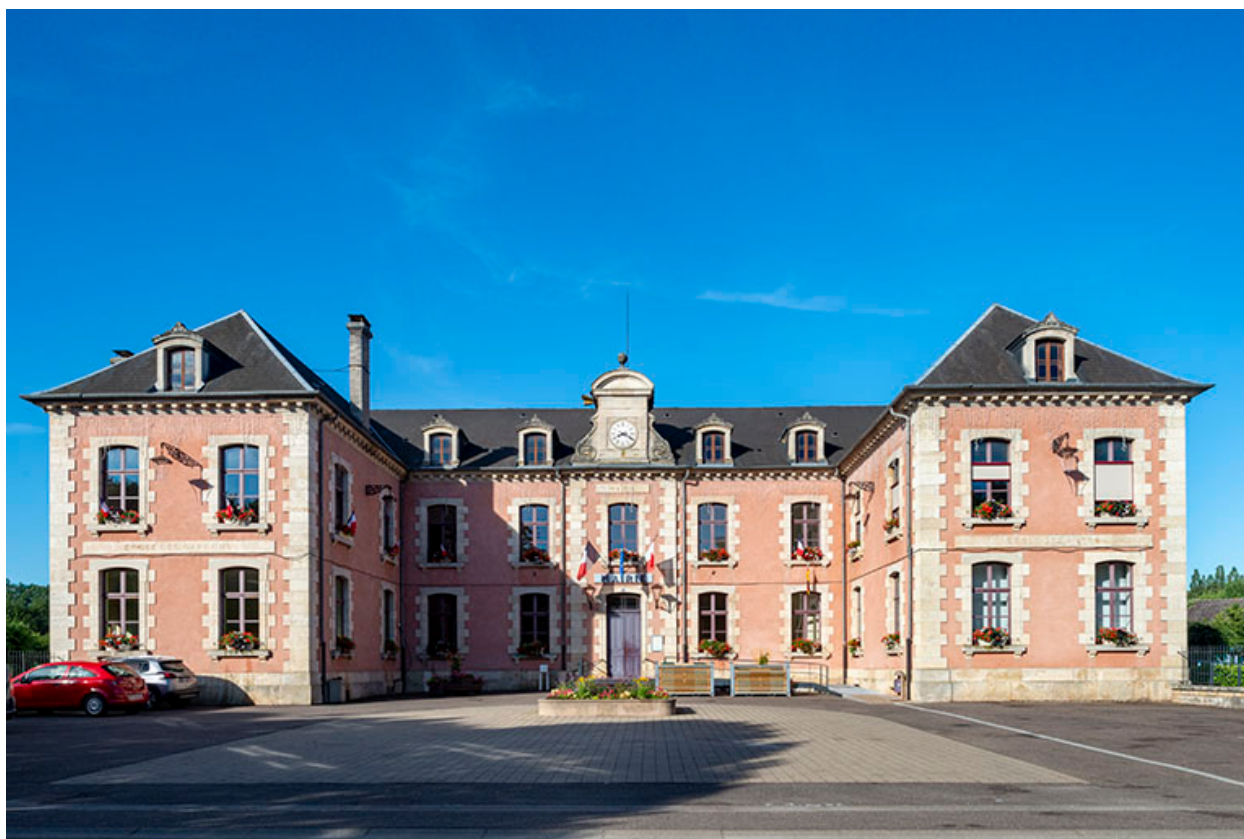
Façade nord-est, vue d'ensemble de face.
