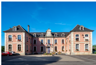
Façade nord-est, vue d'ensemble de face.
