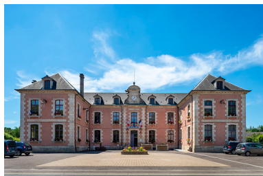
Façade nord-est, vue d'ensemble de face.
