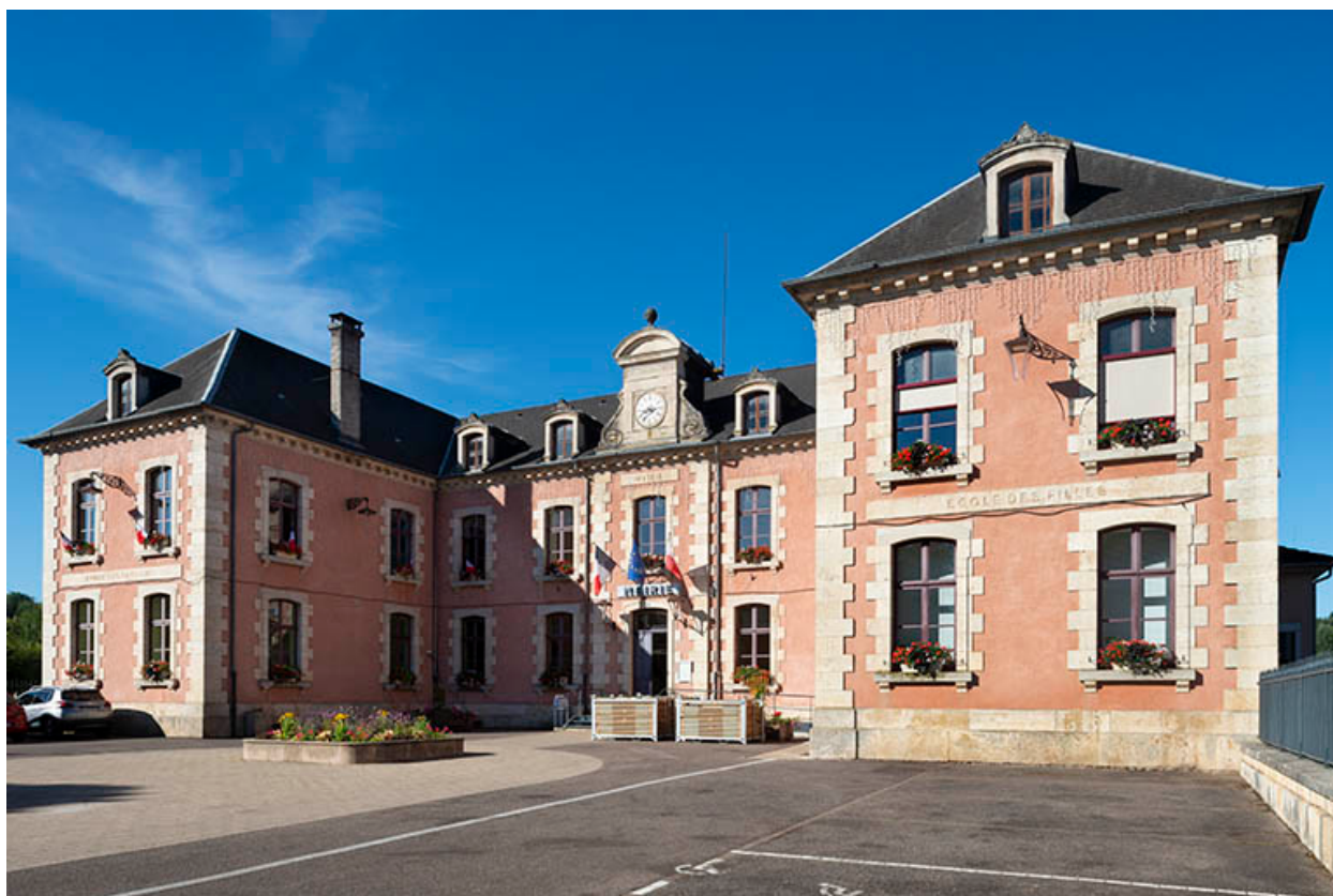
Façade nord-est, vue d'ensemble de trois quarts gauche.
