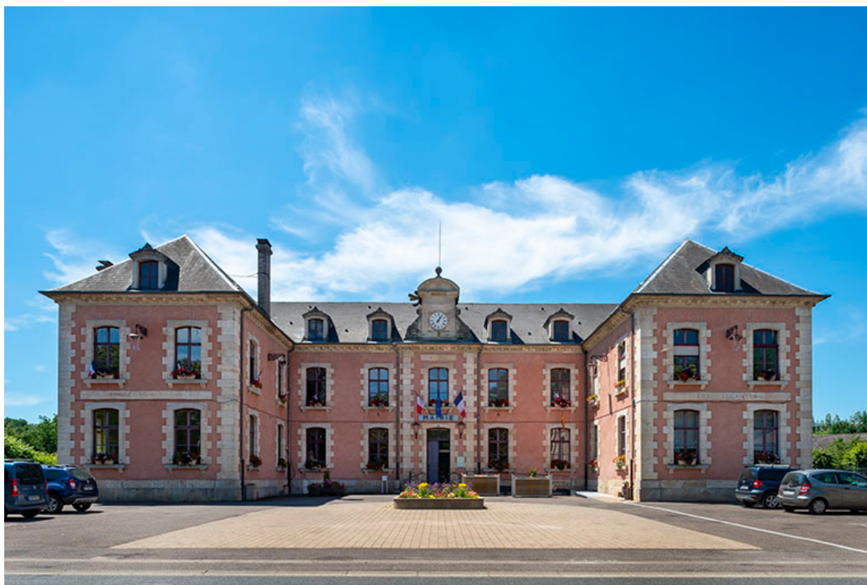
Façade nord-est, vue d'ensemble de face.
