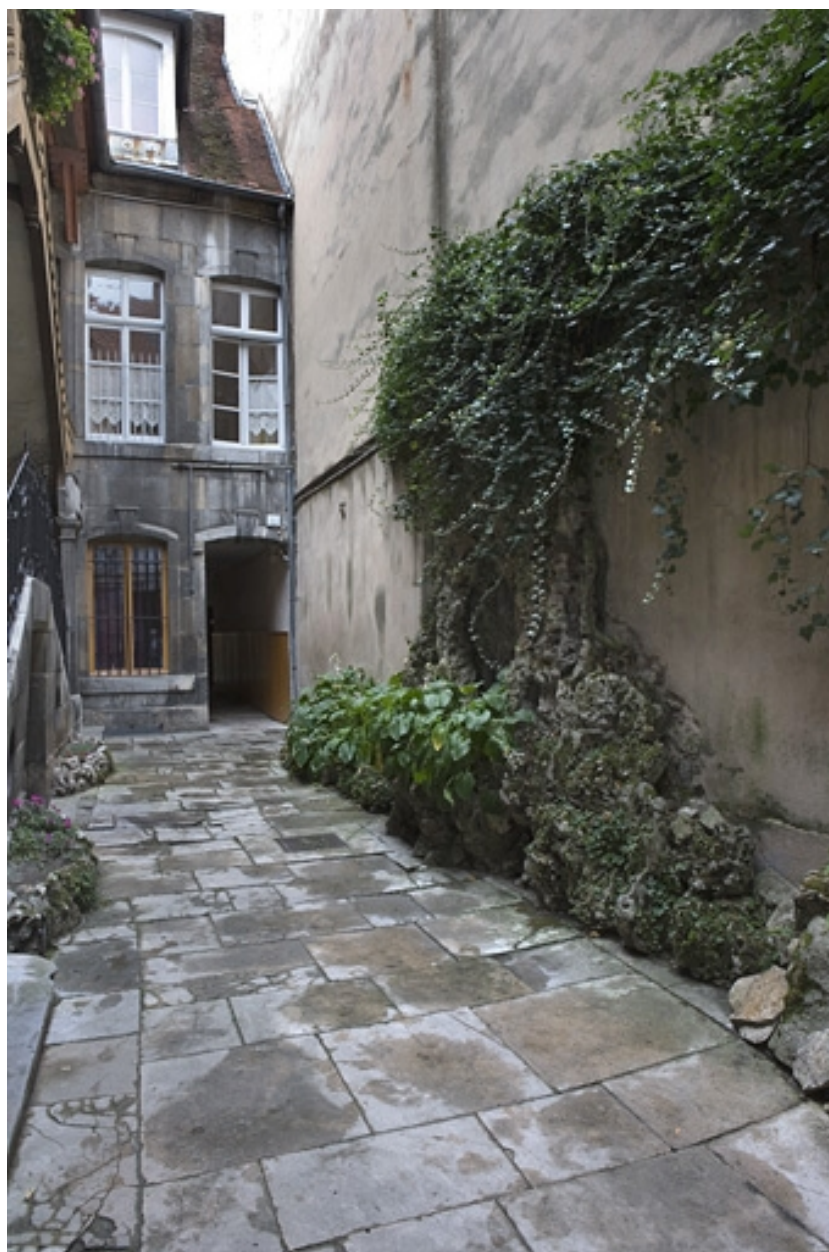
Façade antérieure du logis secondaire sur cour.
