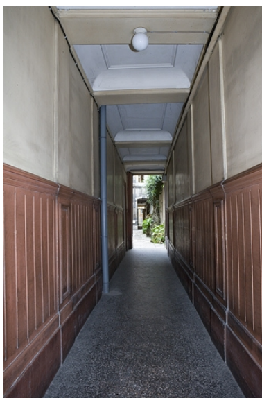
Vue d'ensemble du couloir d'entrée. Phot. Yves Sancey IVR43_20092501315NUC2A
