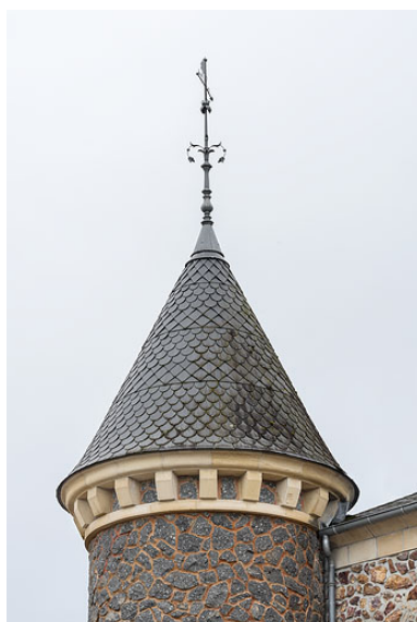
Toiture de la tour de plan circulaire. Phot. Pierre-Marie Barbe-Richaud IVR26_20205800260NUC4A
