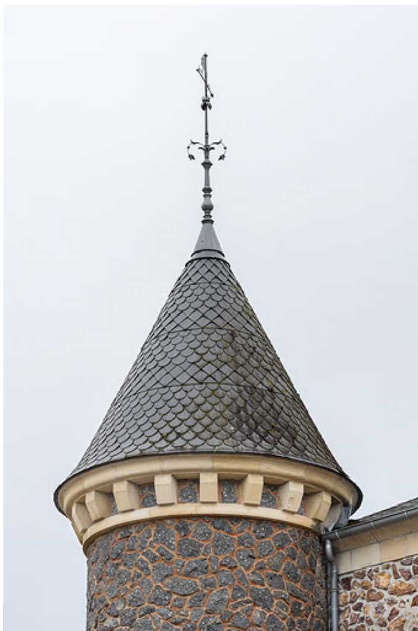
Toiture de la tour de plan circulaire.
