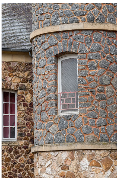
Détail de la tour de plan circulaire. Phot. Pierre-Marie Barbe-Richaud IVR26_20205800264NUC4A
