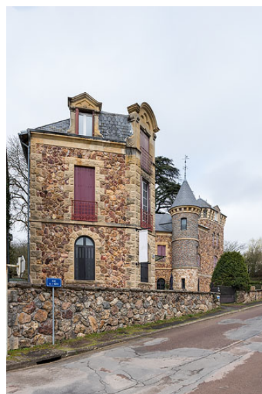
Extrémité du corps sud. Phot. Pierre-Marie Barbe-Richaud IVR26_20205800268NUC4A
