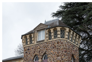
Détail de la tour de plan rectangulaire. Phot. Pierre-Marie Barbe-Richaud IVR26_20205800266NUC4A
