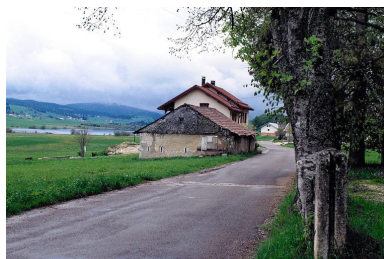
Vue de situation. Phot. Yves Sancey IVR43_19993900179ZA
