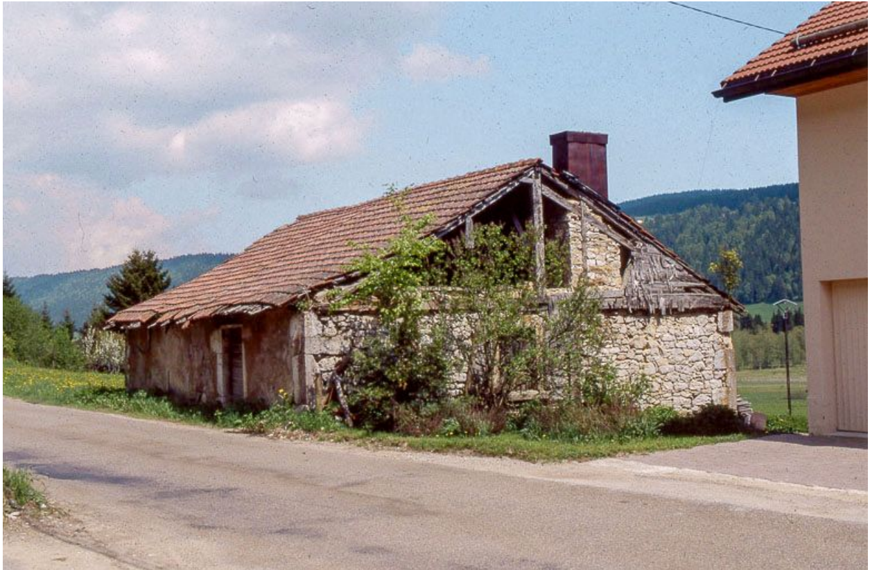
Façade antérieure et face droite.
