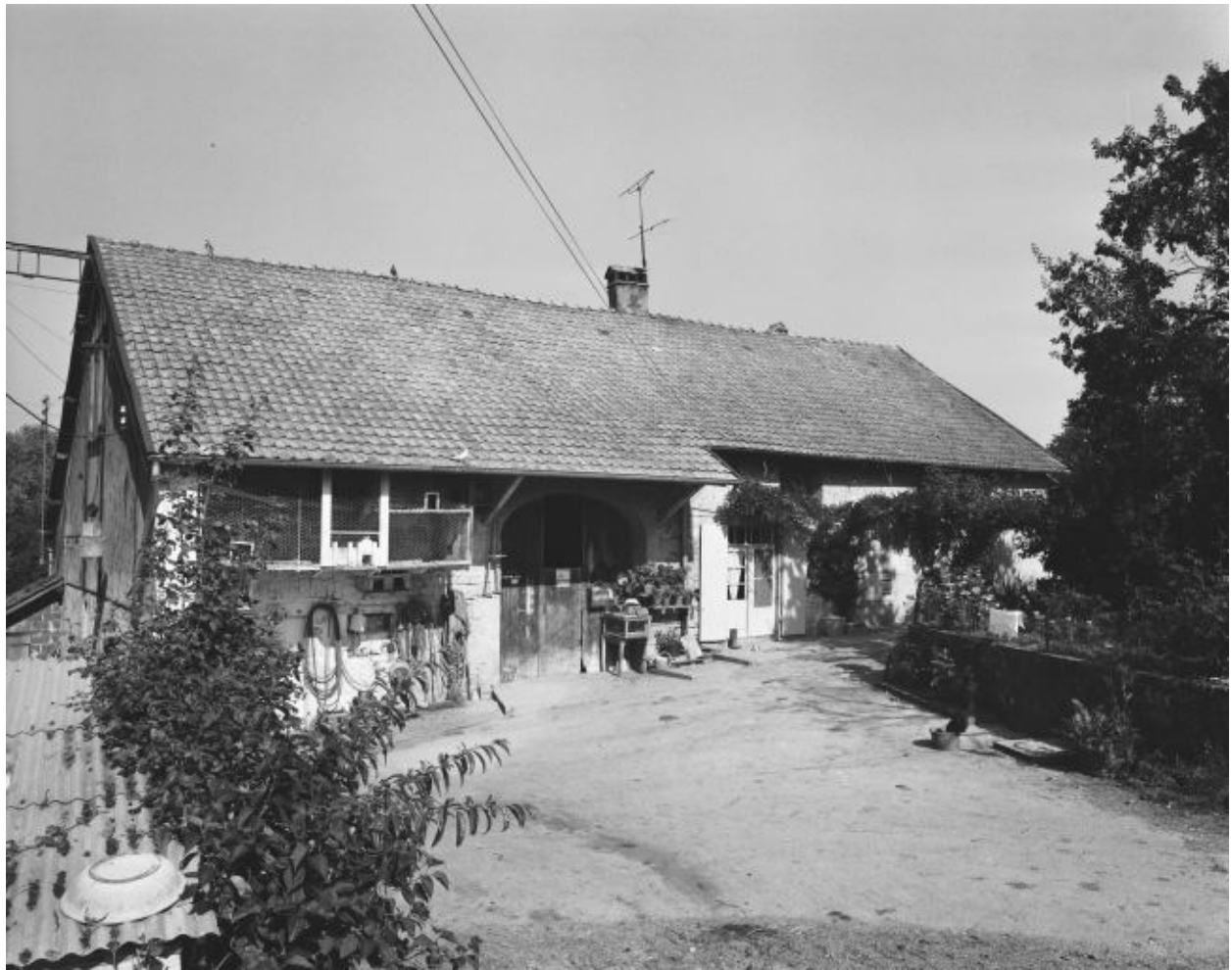
Ferme située rue de la Mairie : façade antérieure.
