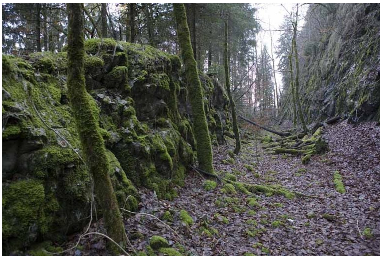
Tranchée du premier tracé abandonnée.
