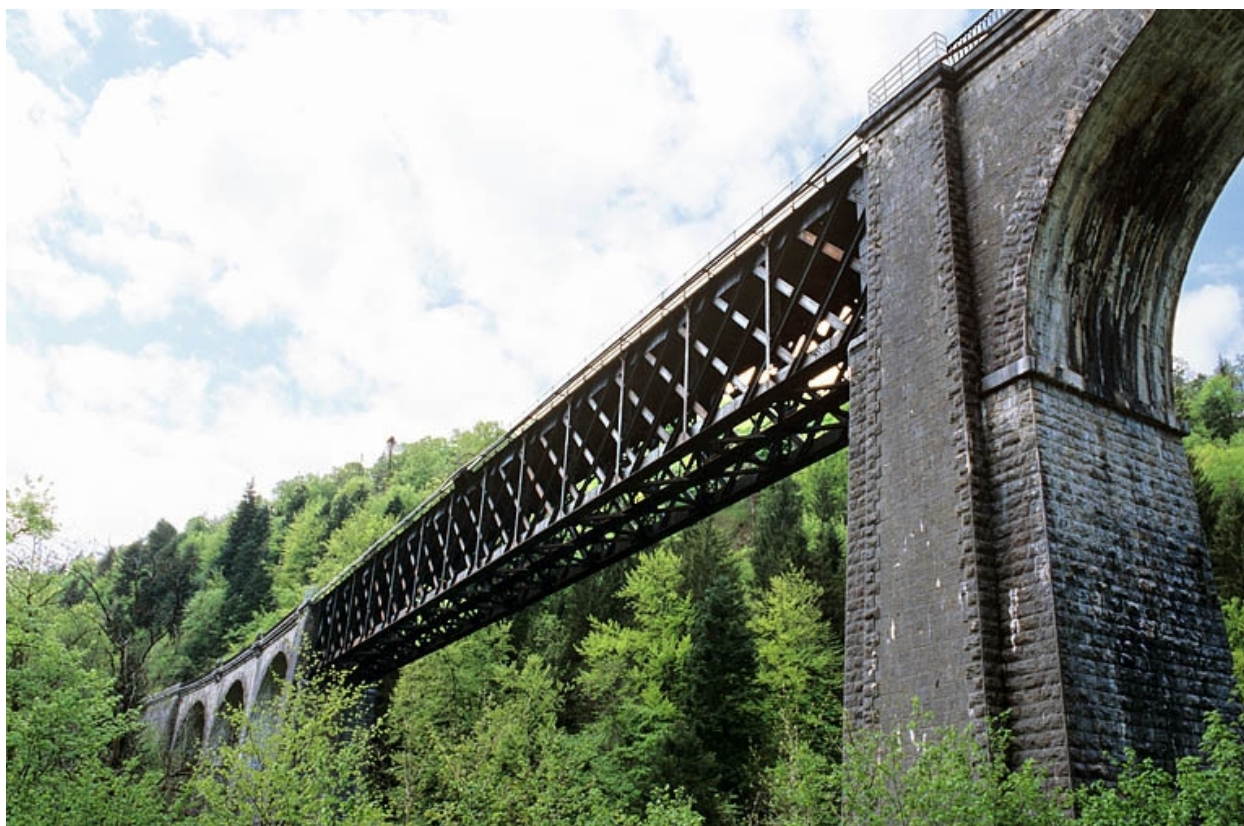
Travée métallique, depuis la route en amont.
