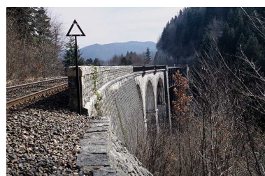
Extrémité rive gauche. Phot. Yves Sancey IVR43_20053900095ZA
