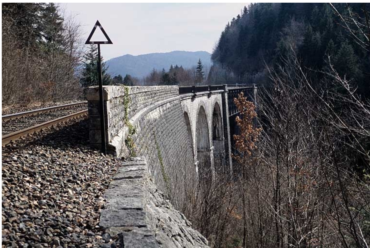
Extrémité rive gauche.
